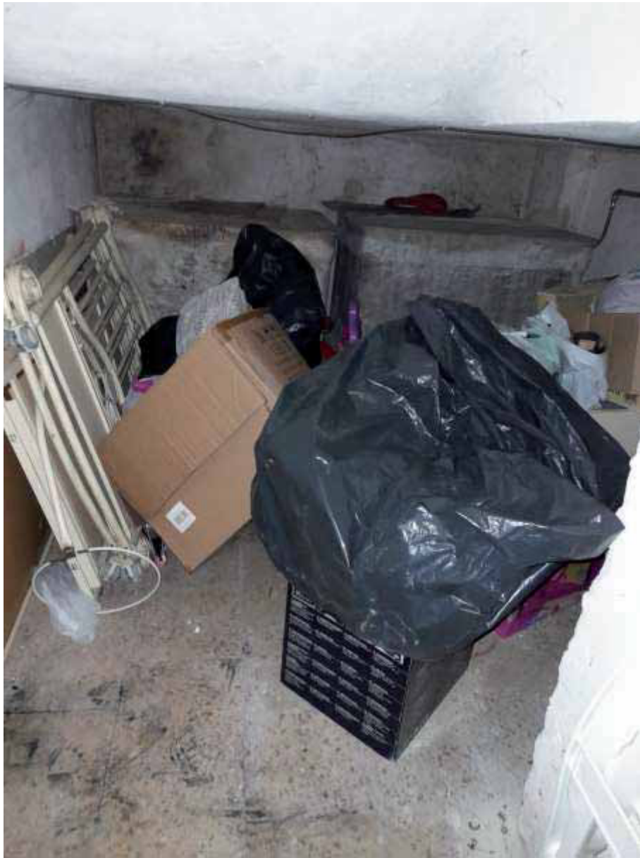
Foto 20) – Vista interno magazzino/sottoscala ( IMMOBILE B )
