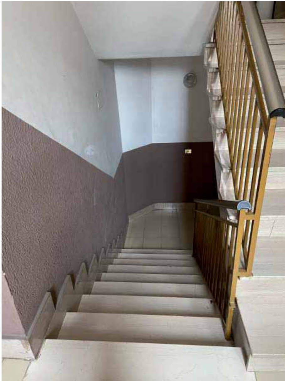
Foto 5) – Vista vano scala condominiale
