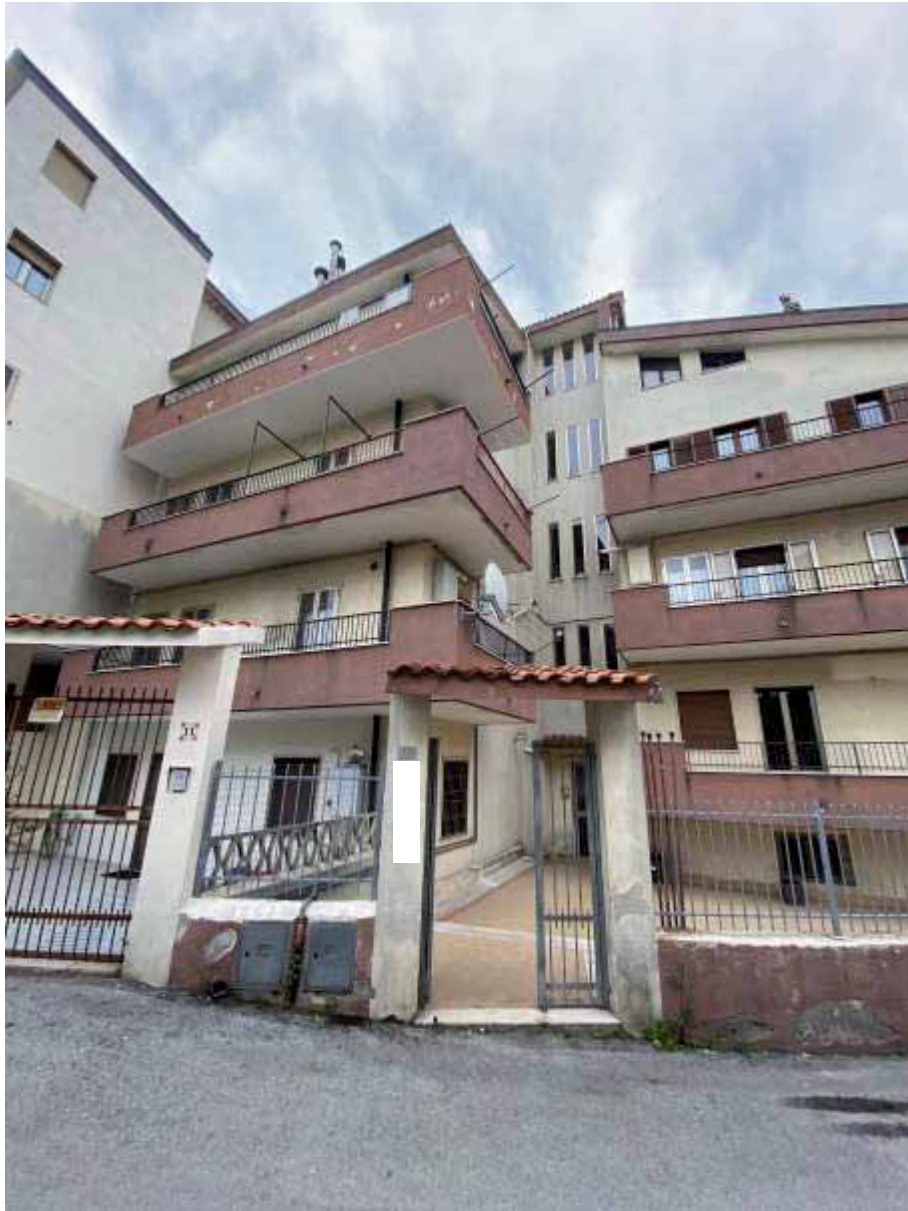
Foto 1) – Ingresso condominio via M. Iacovone n.13- area condominiale esterna
