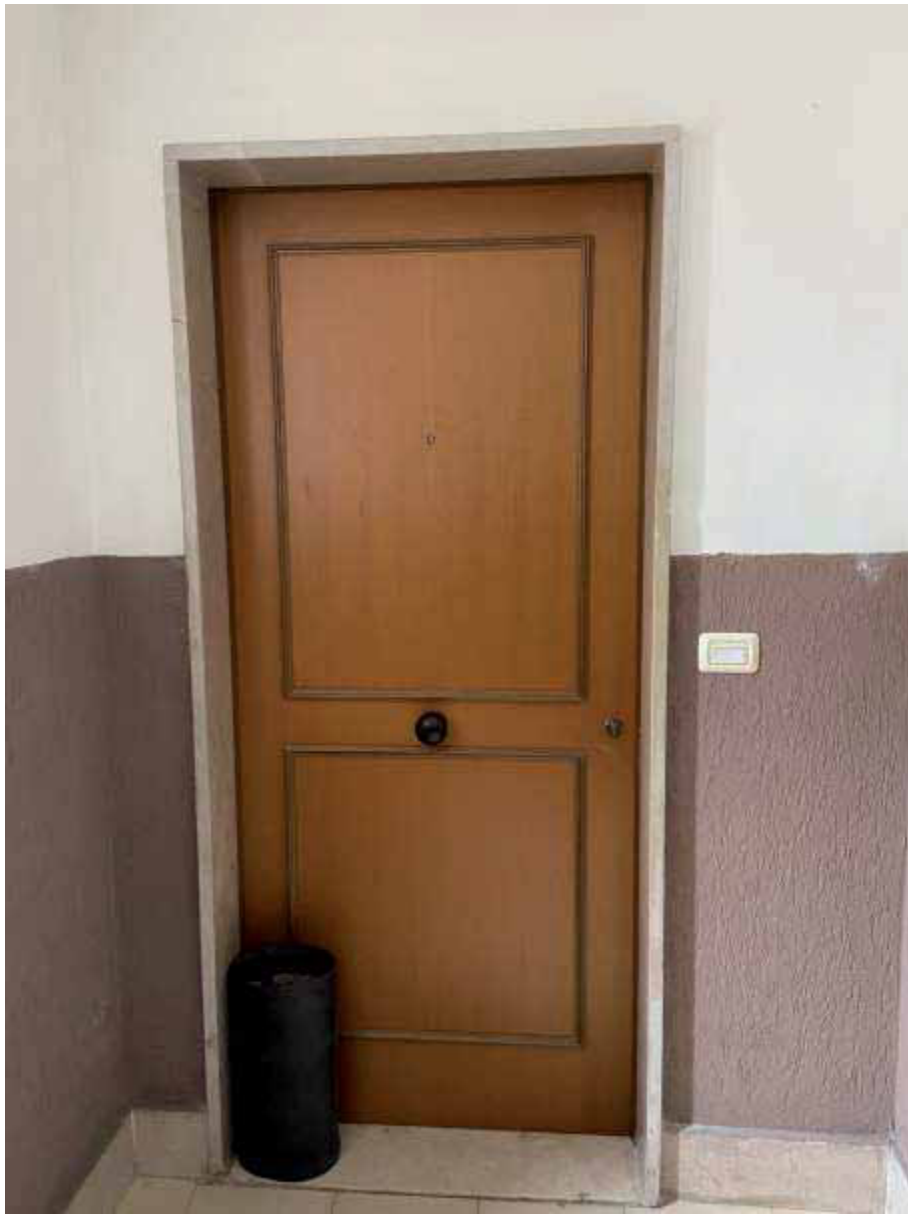
Foto 6) – Vista ingresso appartamento su vano scala ( IMMOBILE A )
