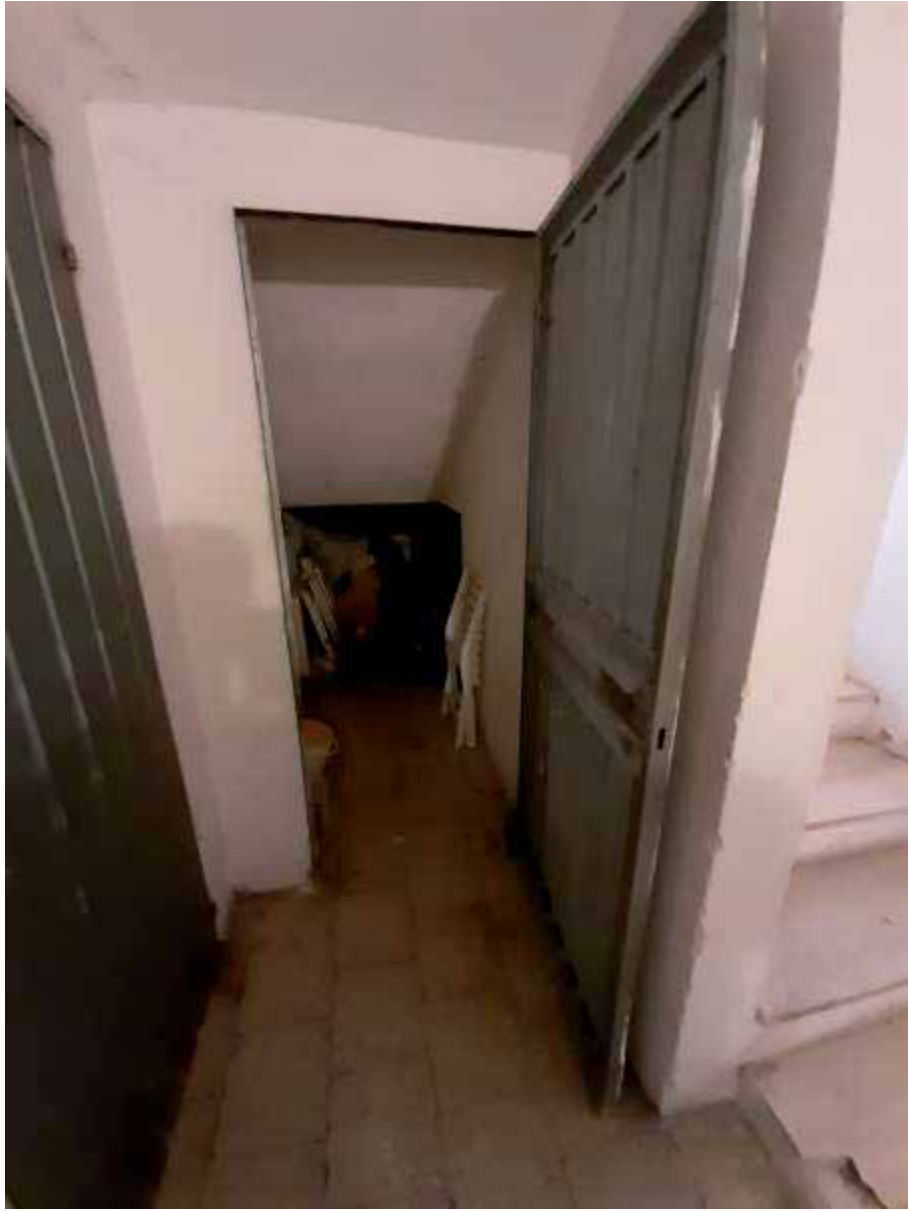
Foto 19.1) – Vista magazzino/sottoscala ( IMMOBILE B )
