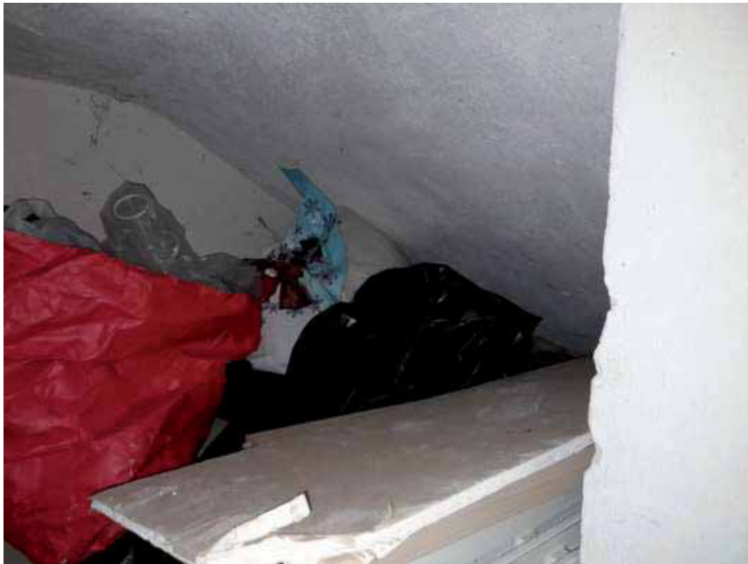
Foto 20.1) – Vista interno magazzino/sottoscala ( IMMOBILE B )
