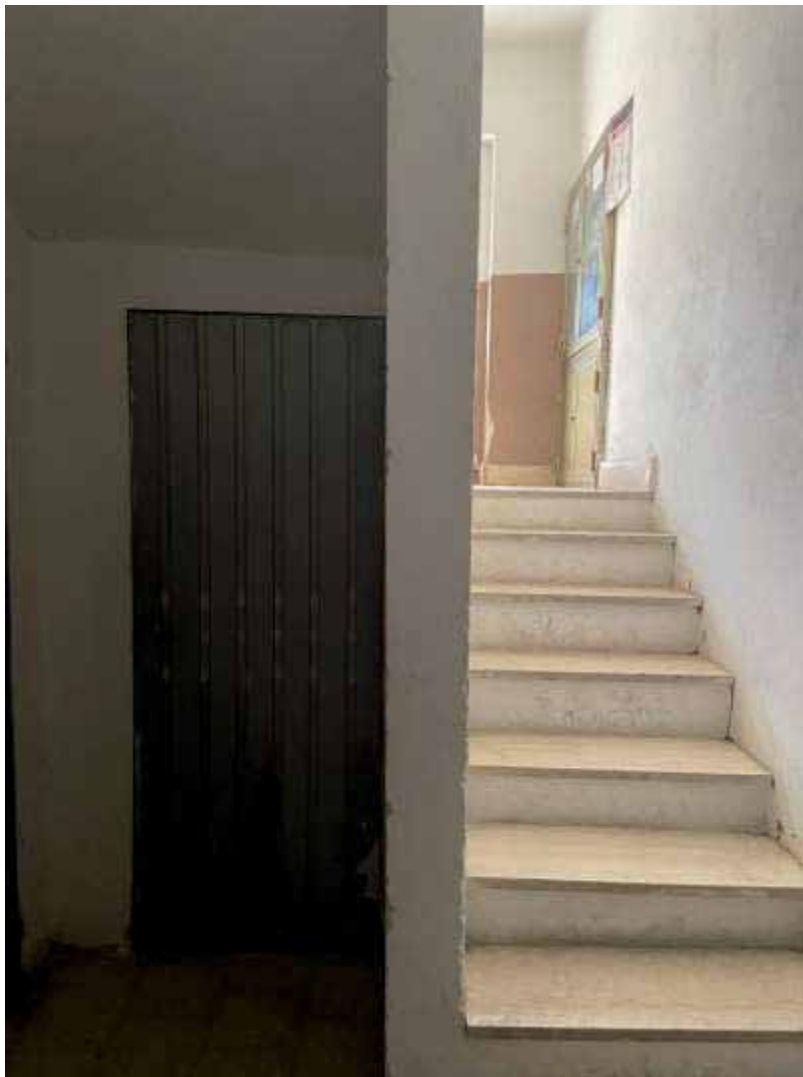
Foto 19) – Vista ingresso magazzino/sottoscala ( IMMOBILE B )
