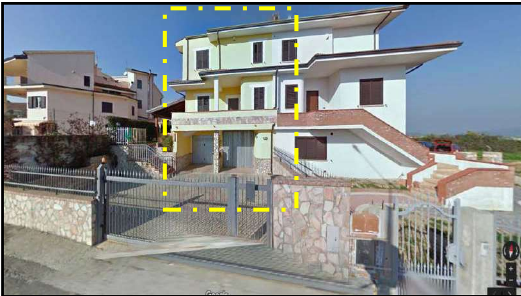
Figura 3 – Prospetto fabbricato con individuazione degli immobili pignorati.
