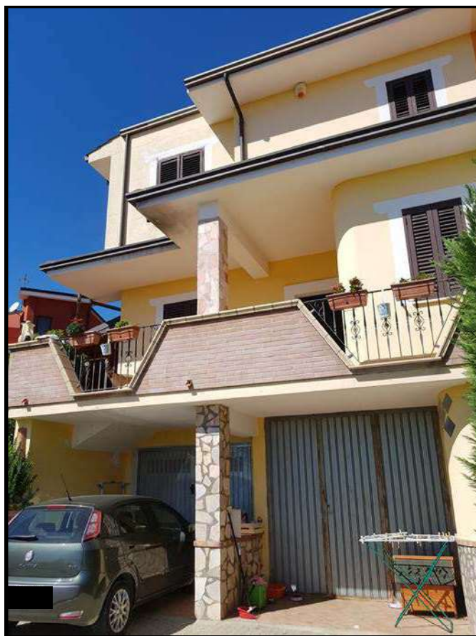
Figura 4 - Accesso principale al seminterrato. Foglio 43, particella 295, sub.5
