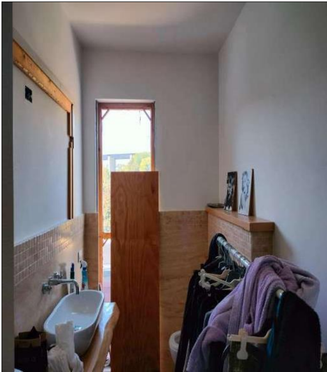
Bagno non ultimato
