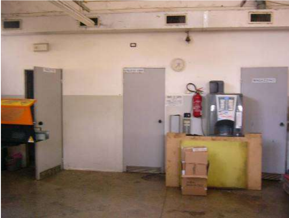
Foto n. 16. Opificio. Accessi a magazzino, bagni e spogliatoi operai.
