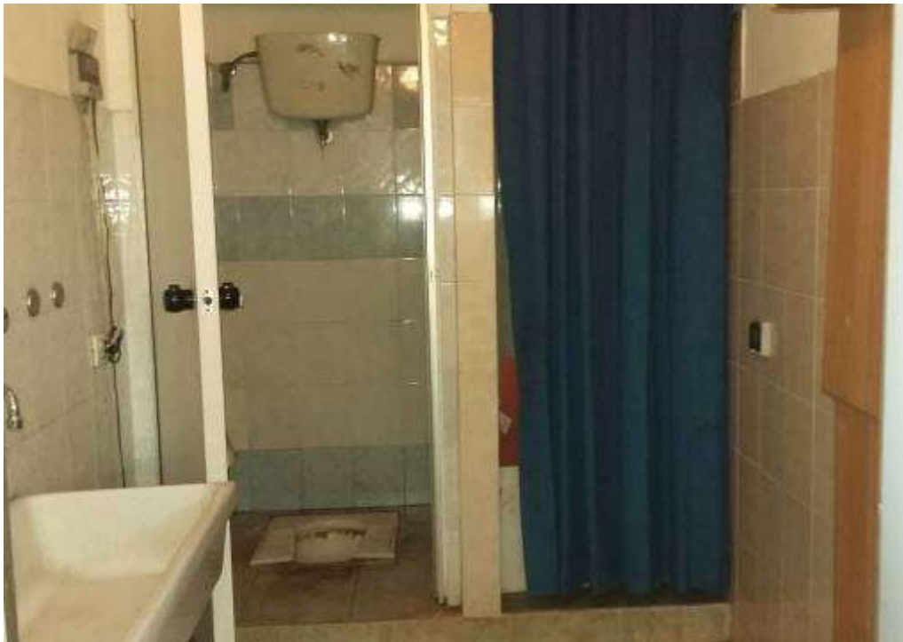
Foto n. 17. Opificio. Bagni operai.
