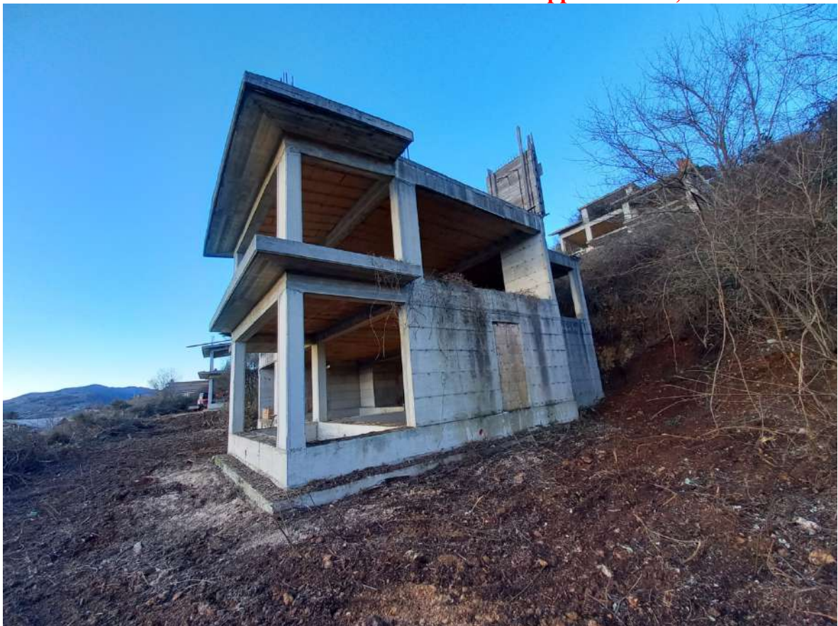
Foto n. 14 – Rustico del villino distinto con il mappale n. 1072, lato SX
