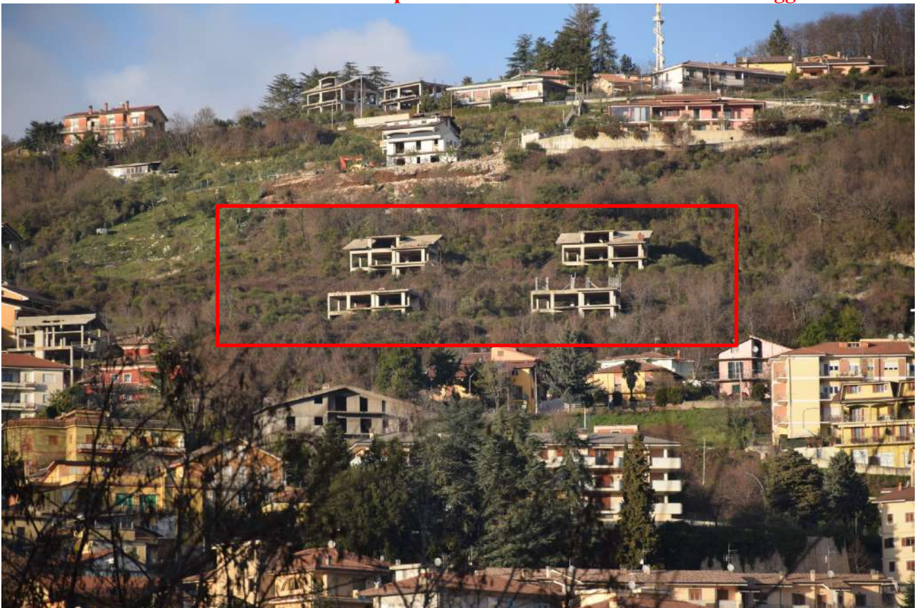
Foto n. 2 – Rustici eseguiti ripresi dalla zona bassa del comune di Fiuggi
