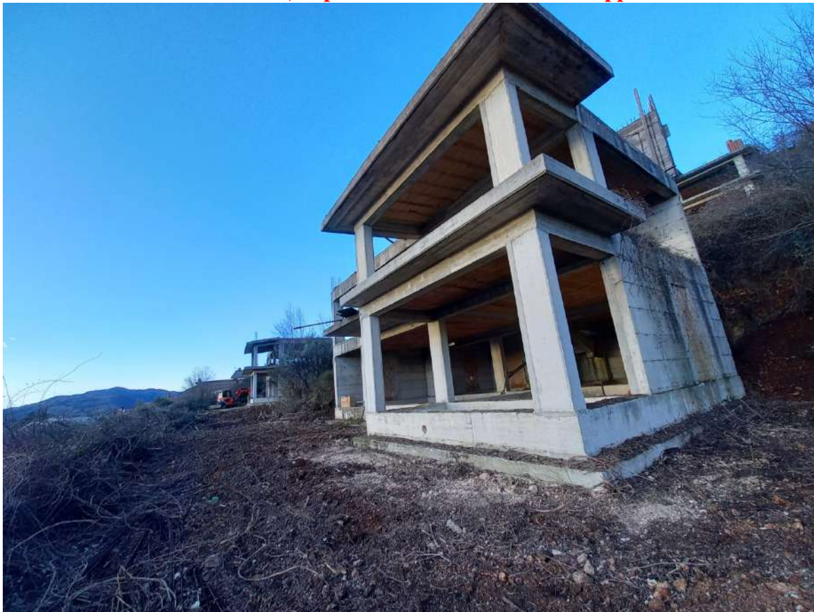
Foto n. 15 – Rustici dei villini, rispettivamente distinti con i mappali nn. 1072 e 1071
