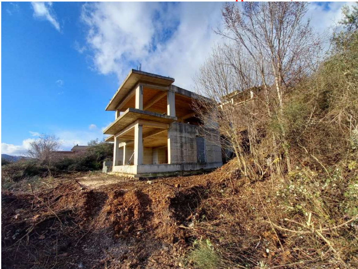
Foto n. 12 – Rustico del villino distinto con il mappale n. 1071, lato SX
