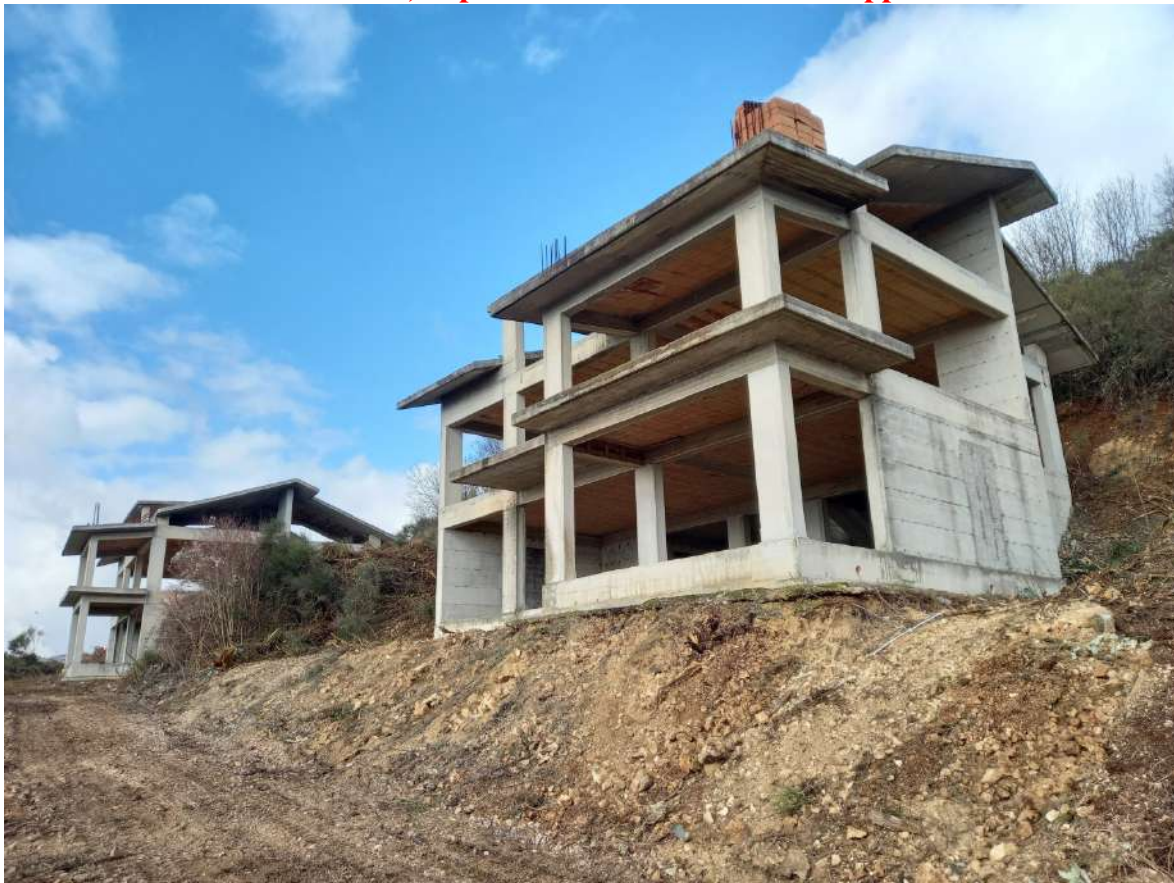
Foto n. 9 – Rustici dei villini, rispettivamente distinti con i mappali nn. 1070 e 1069
