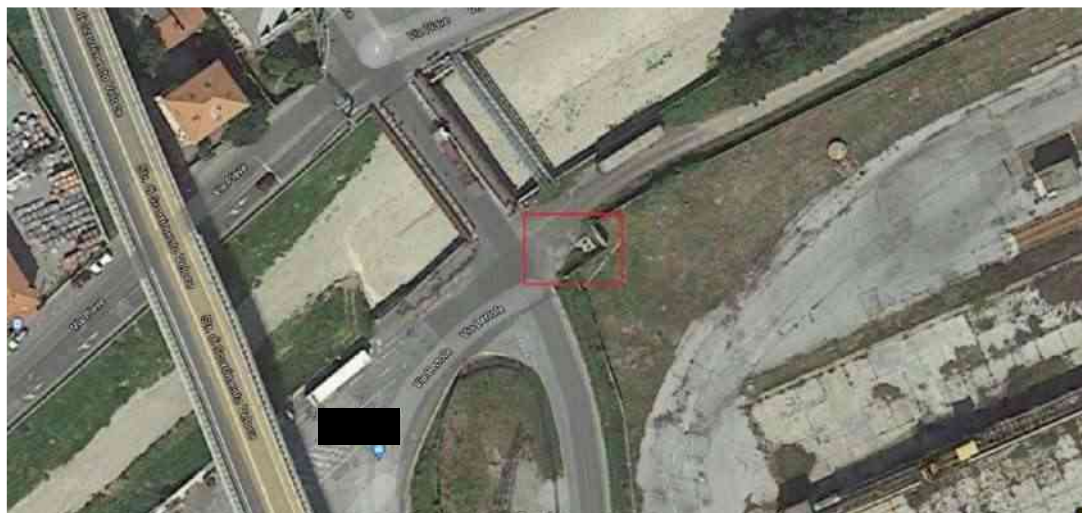
Figura 1 - particolare: pozzetto di collettamento scarico di [redacted] da cui parte la competenza di manutenzione di Consorzio spa
