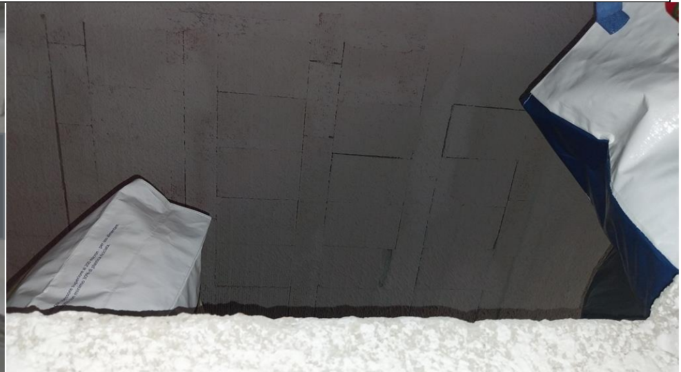
Foto32_Sottotetto_scorcio intradesso struttura falda tetto
