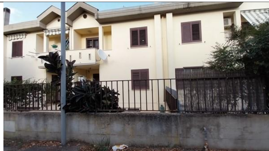
Foto6_Esterno_vista esterna lato strada pedonale_2
