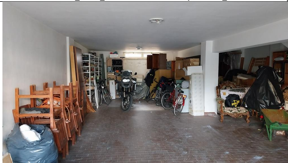
Foto11_Seminterrato_vista posto auto
