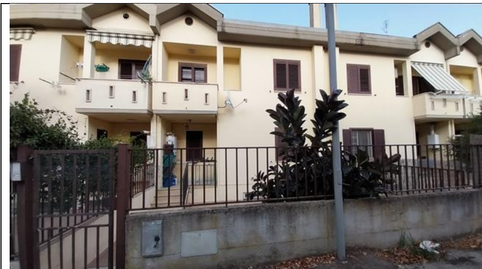
Foto5_Esterno_vista esterna lato strada pedonale
