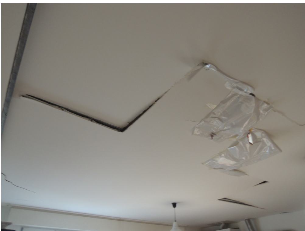
Foto 16 – magazzino piano primo adibito illegittimamente ad appartamento (corpo A)
