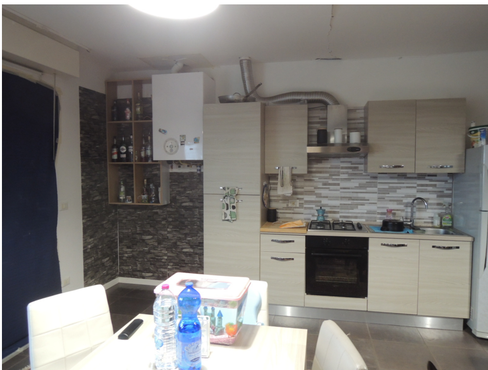
Foto 12 – magazzino piano primo adibito illegittimamente ad appartamento (corpo A)
