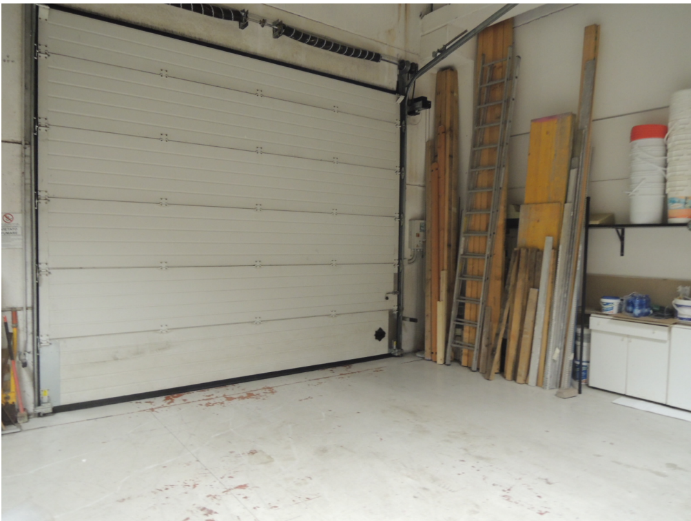
Foto 6 – magazzino piano terra (corpo A)
