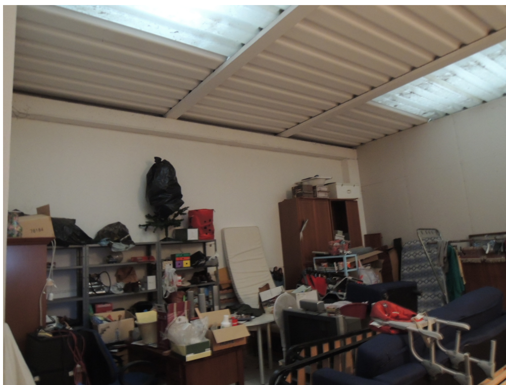
Foto 10 – magazzino piano primo (corpo A)
