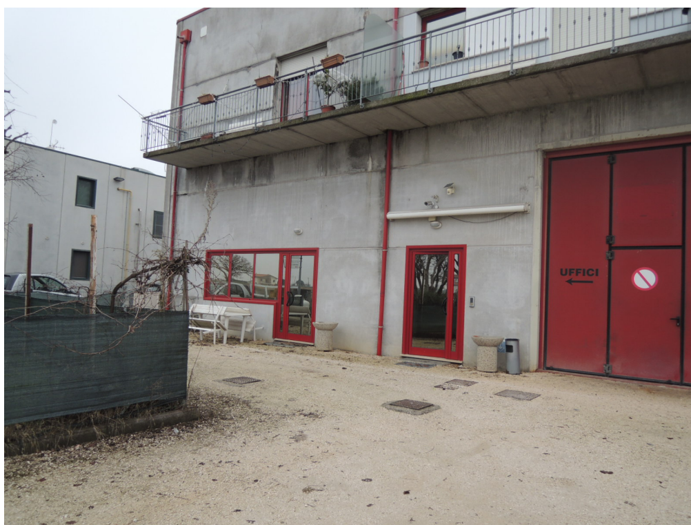
Foto 2 - veduta esterna dell'u.i. artigianale - corpo A
