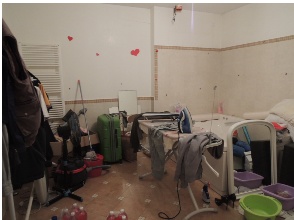
Foto 24 – bagno (corpo B)
