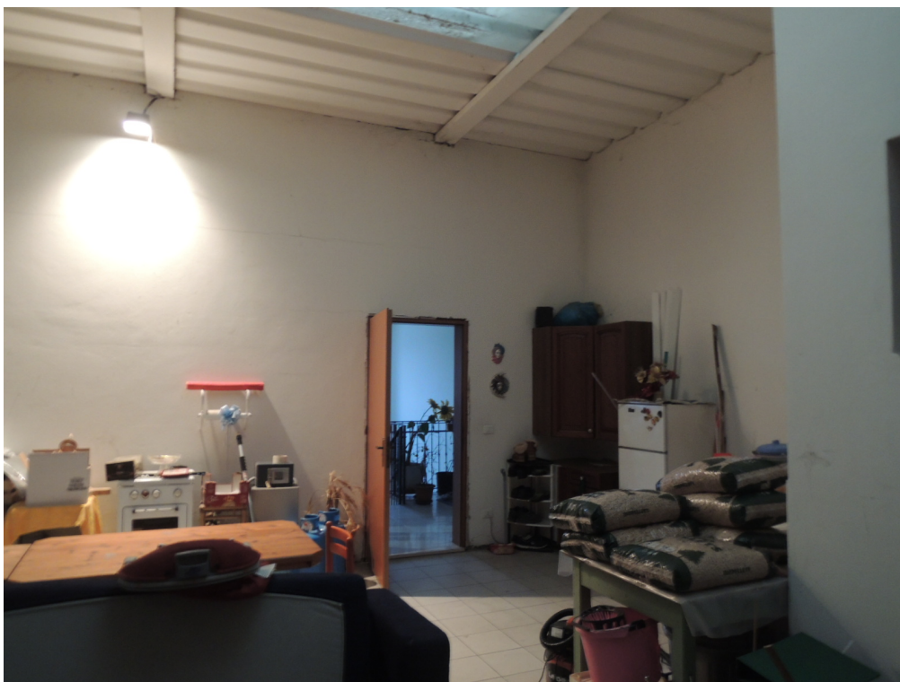
Foto 11 – magazzino piano primo (corpo A)
