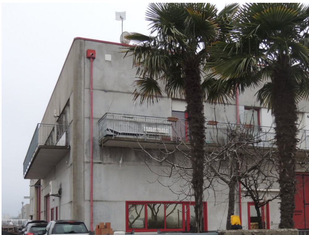
Foto 18 - veduta esterna dell'edificio nella zona d'angolo ove ubicato l'appartamento al piano primo (corpo B)
