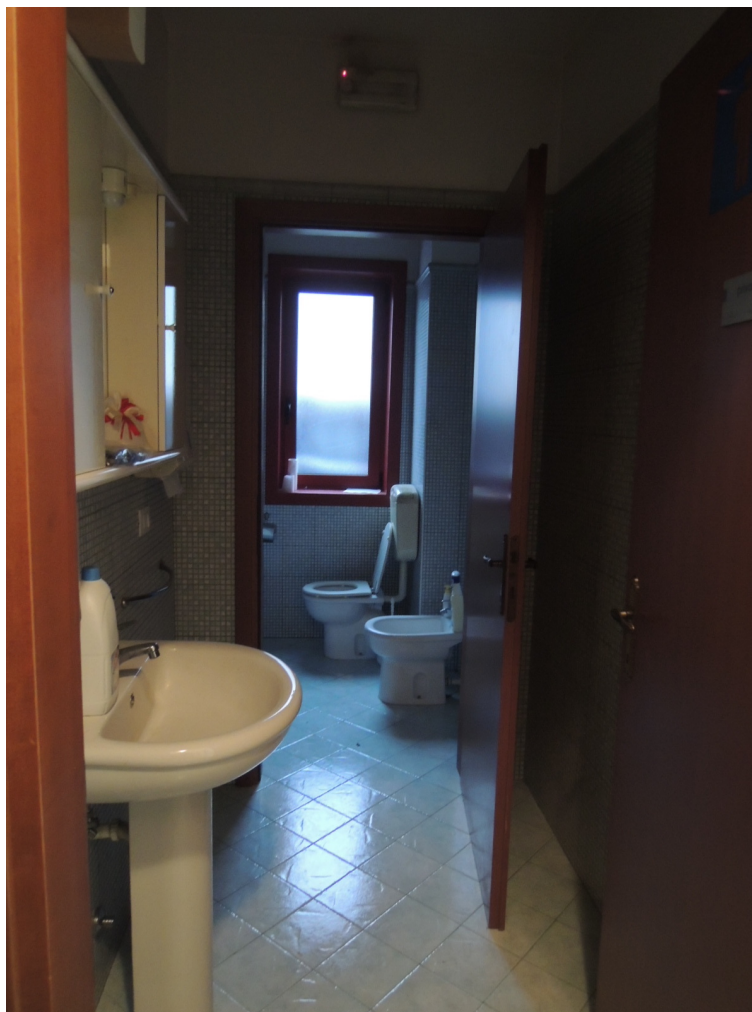
Foto 9 – bagno dell'ufficio piano terra (corpo A)
