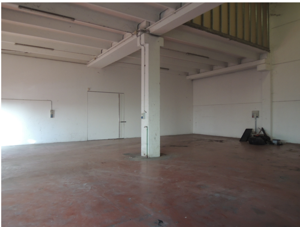
Foto 4 – magazzino piano terra (corpo A)
