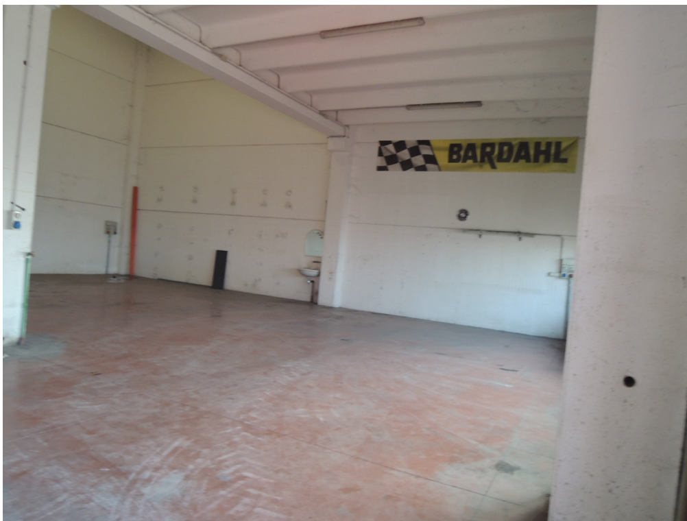
Foto 3 – magazzino piano terra (corpo A)
