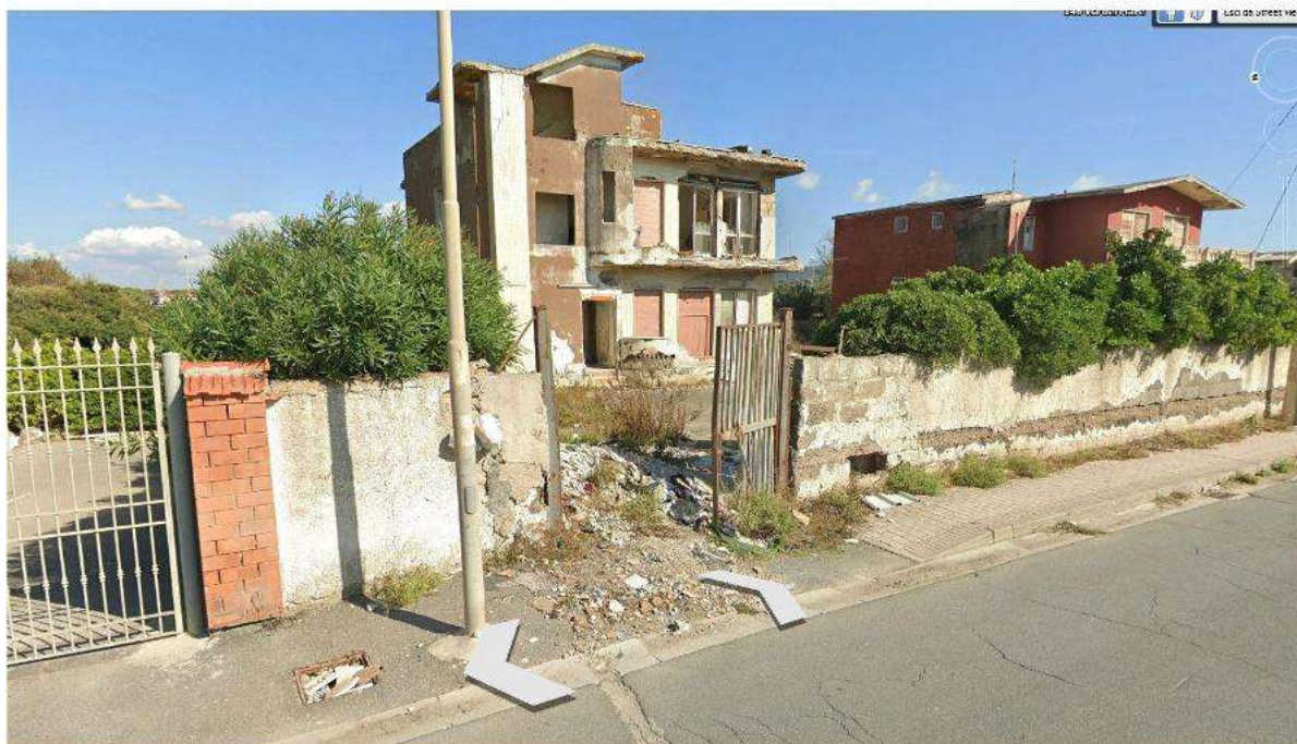
Foto n. 3 ( vista immobile da via del Mare)
