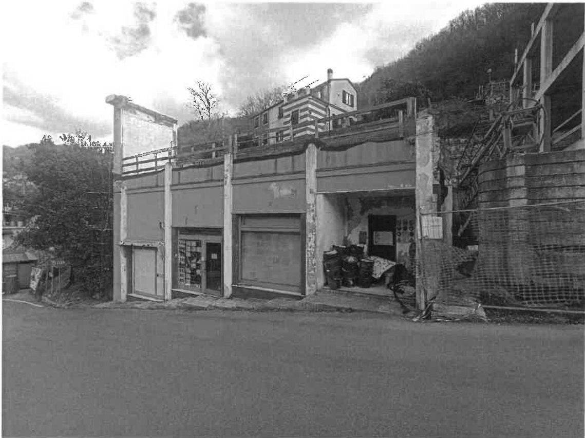
FOTO 3: BENE 1 - VEDUTA GENERALE DELL'IMMOBILE OGGETTO DI STIMA
