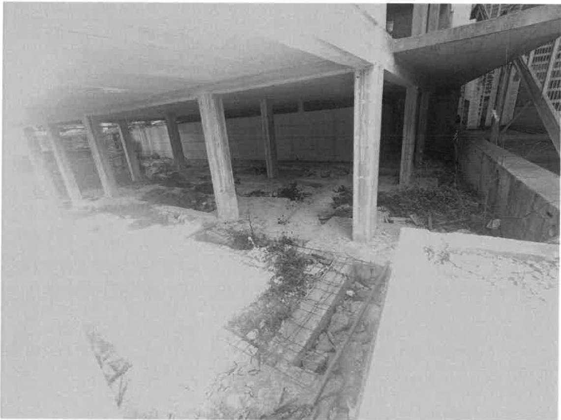
Foto 29: BENE 2 – FABBRICATO IN COSTRUZIONE
