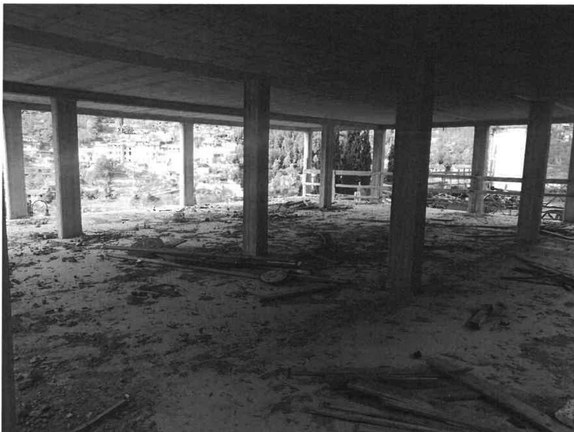
Foto 31: BENE 2 – FABBRICATO IN COSTRUZIONE
