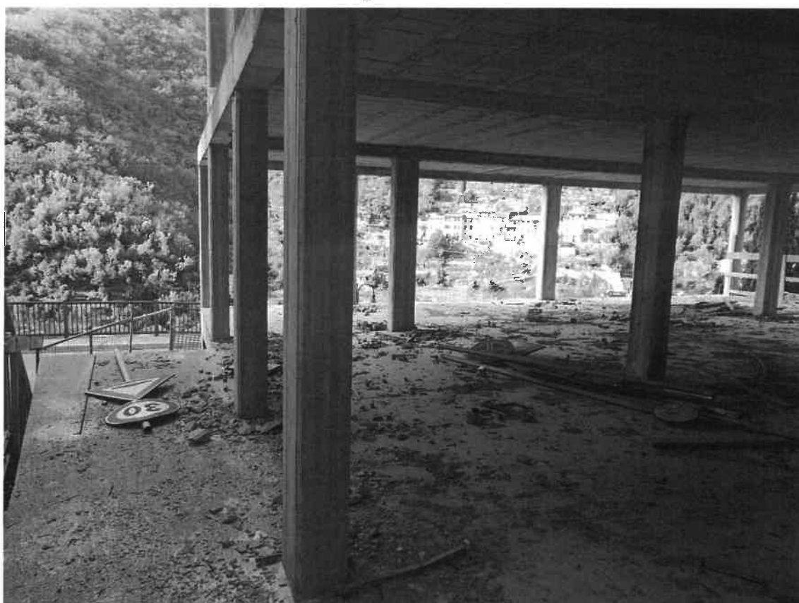
Foto 32: BENE 2 – FABBRICATO IN COSTRUZIONE
