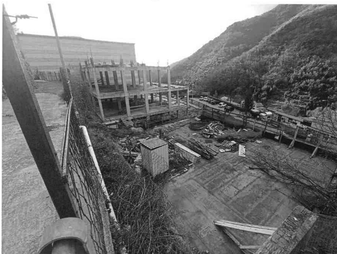
Foto 24: BENE 2 – FABBRICATO IN COSTRUZIONE
