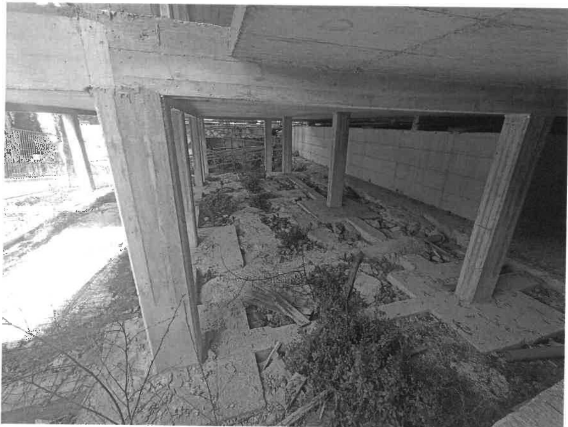
FOTO 28: BENE 2 – FABBRICATO IN COSTRUZIONE
