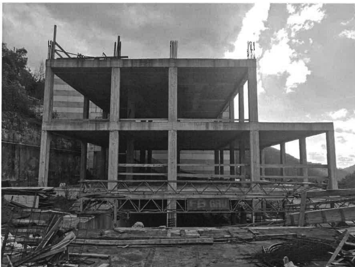
Foto 23: BENE 2 – FABBRICATO IN COSTRUZIONE
