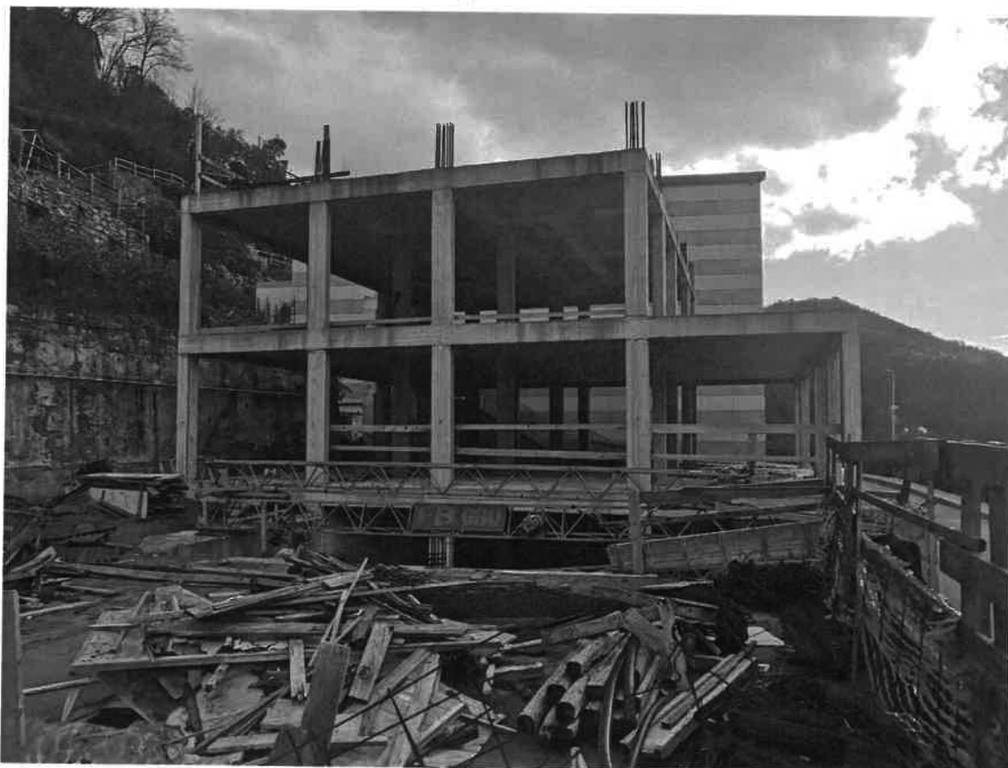
FOTO 22: BENE 2 – FABBRICATO IN COSTRUZIONE
