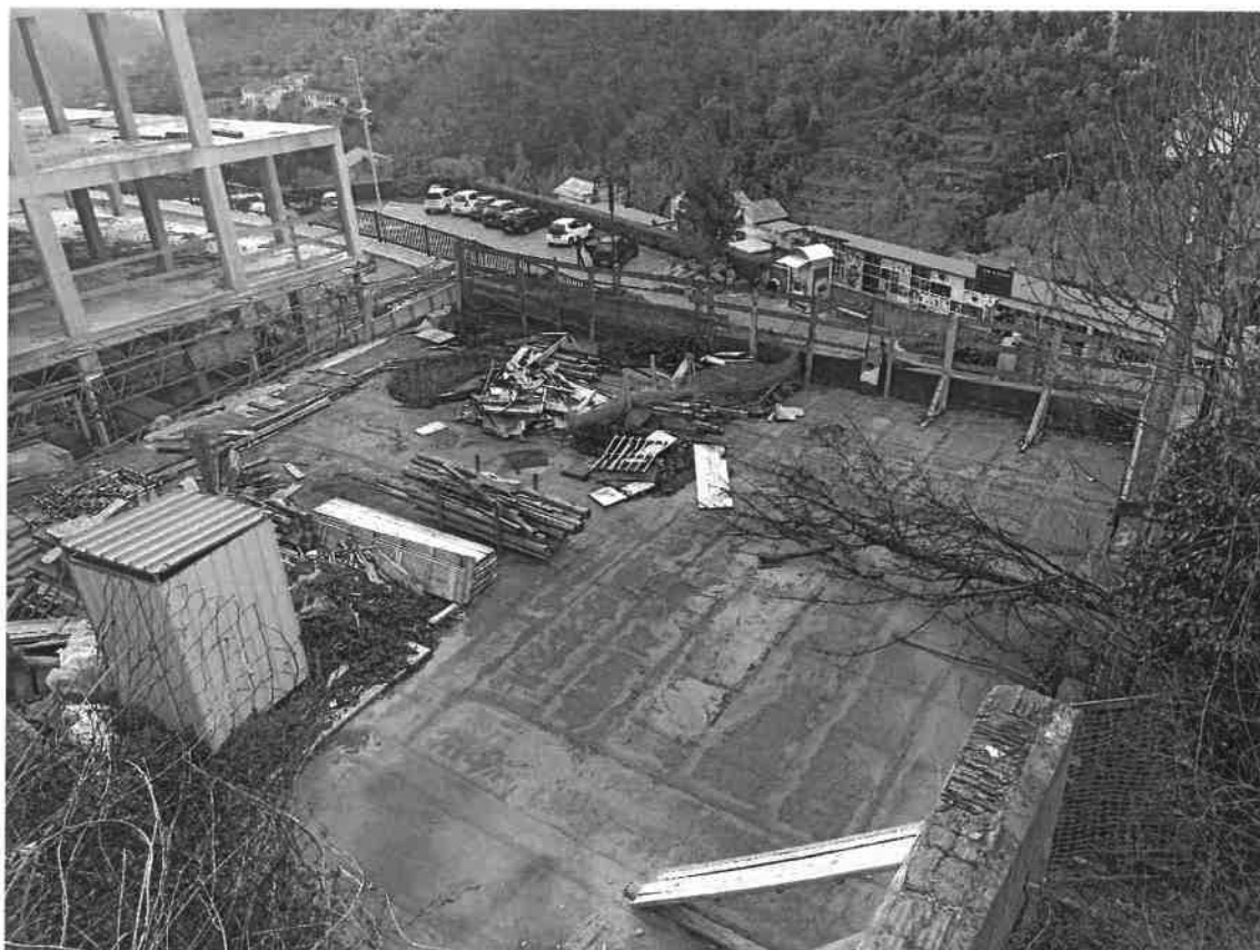
FOTO 2: BENE 1 - VEDUTA DELLA COPERTURA DELL'IMMOBILE OGGETTO DI STIMA
