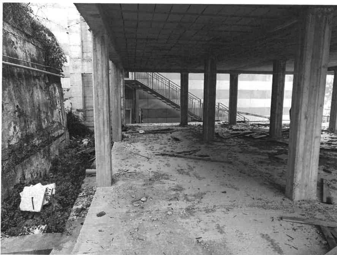
FOTO 35: BENE 2 – FABBRICATO IN COSTRUZIONE
