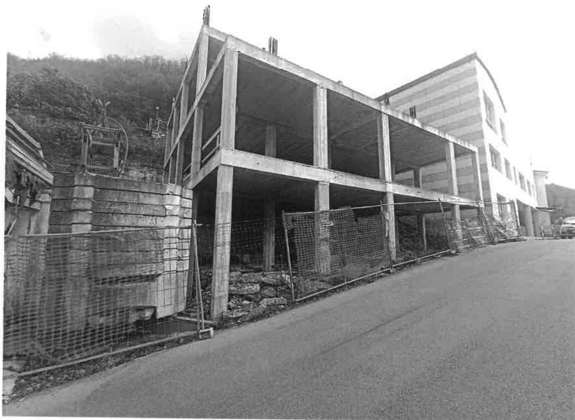
FOTO 21: BENE 2 – FABBRICATO IN COSTRUZIONE
