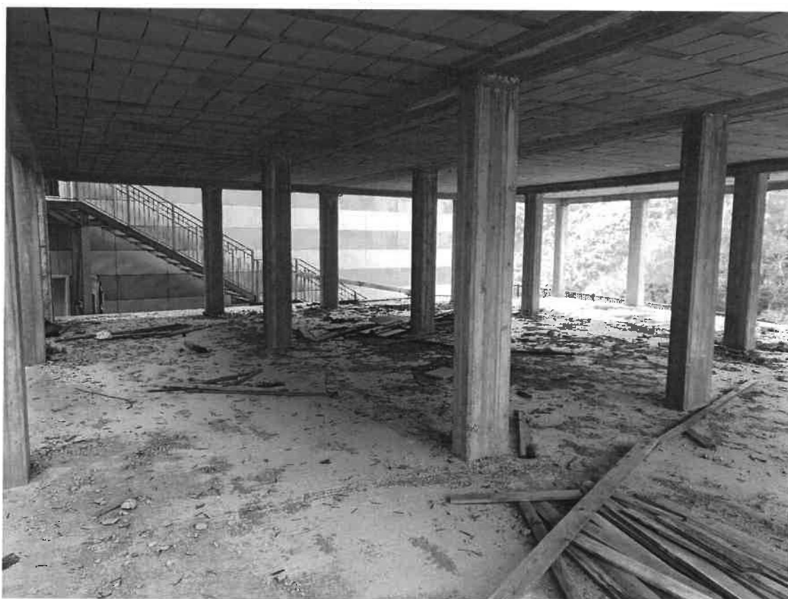
FOTO 34: BENE 2 – FABBRICATO IN COSTRUZIONE
