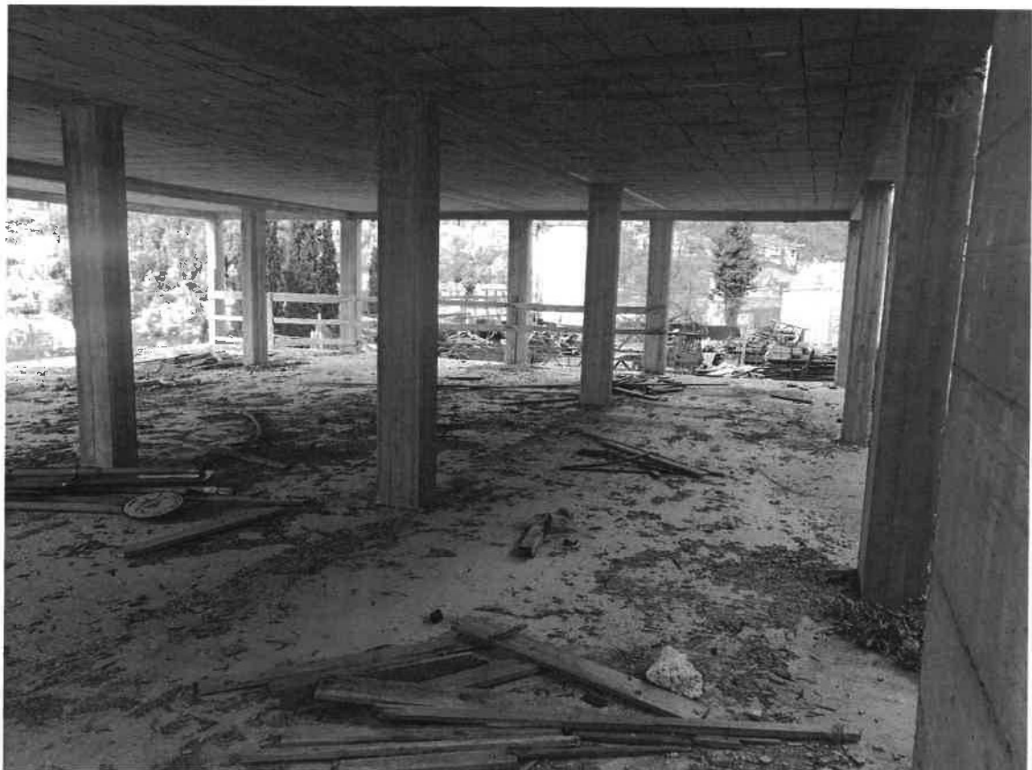
Foto 30: BENE 2 – FABBRICATO IN COSTRUZIONE
