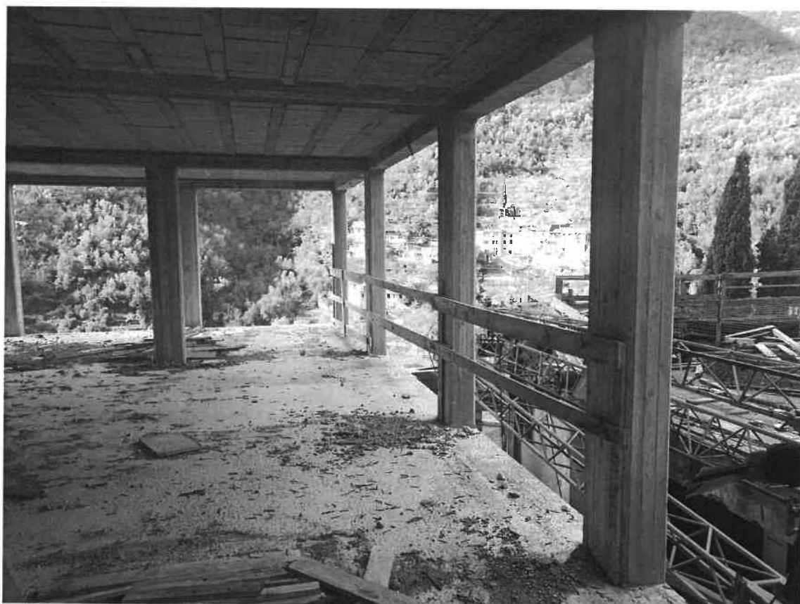
FOTO 33: BENE 2 – FABBRICATO IN COSTRUZIONE
