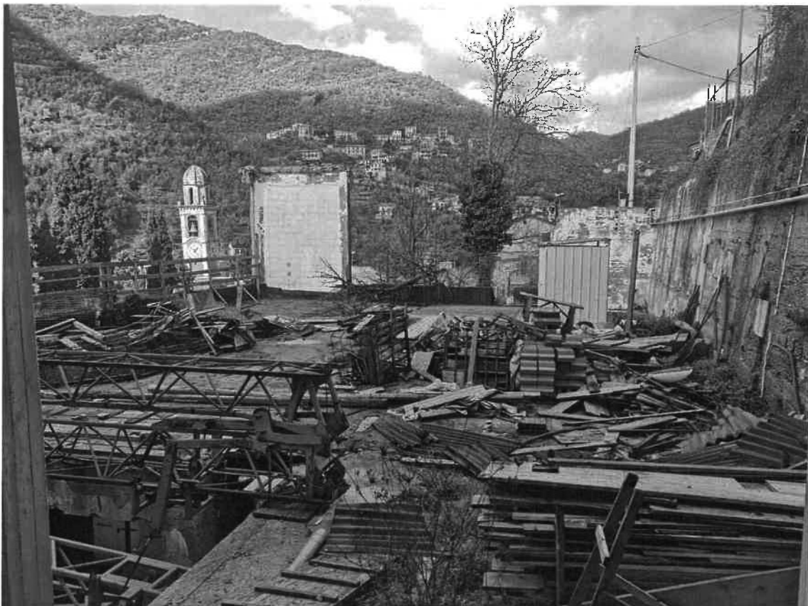
FOTO 4: BENE 1 - VEDUTA DELLA COPERTURA DELL'IMMOBILE OGGETTO DI STIMA
