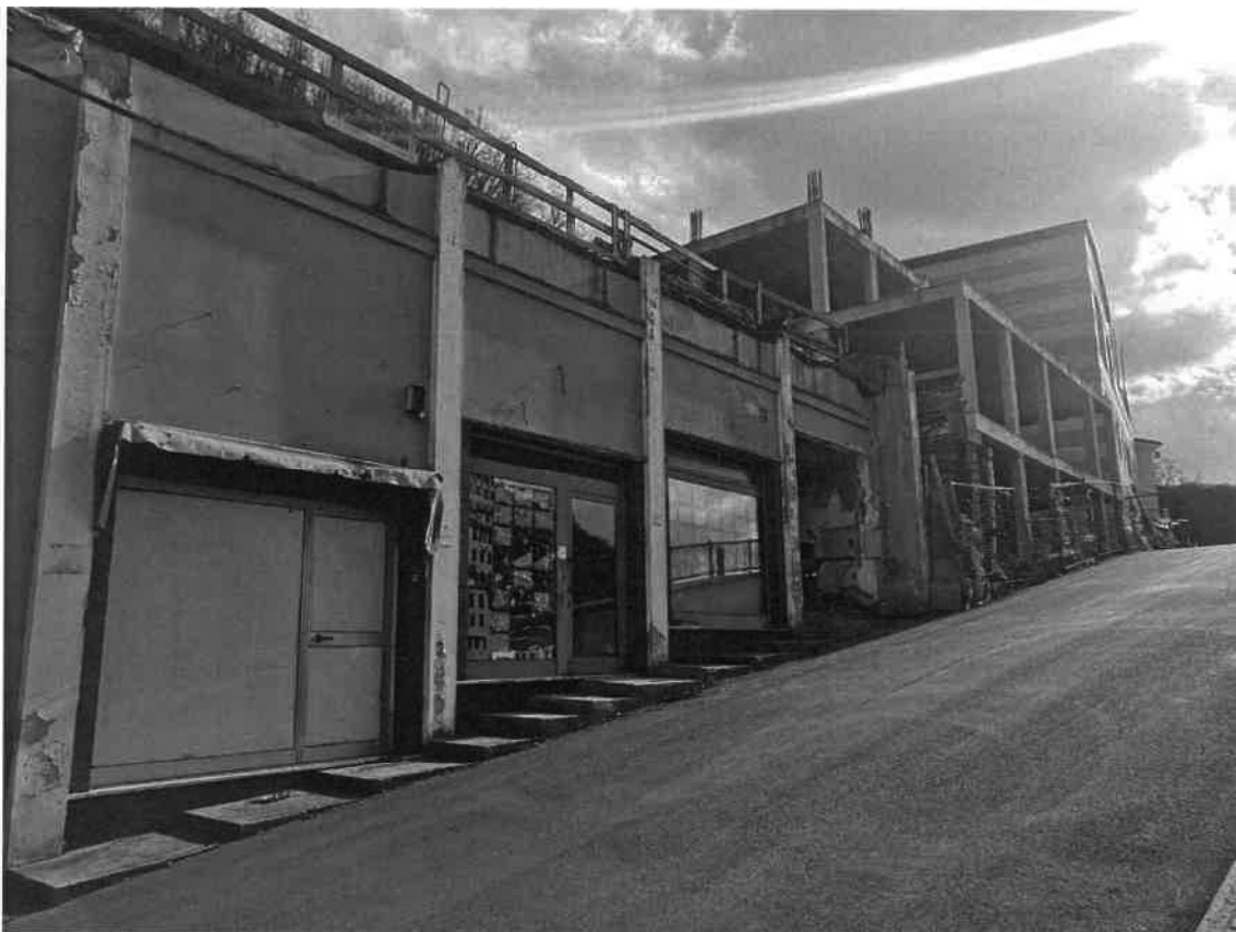
FOTO 1: BENE 1 - VEDUTA GENERALE DELL'IMMOBILE OGGETTO DI STIMA
