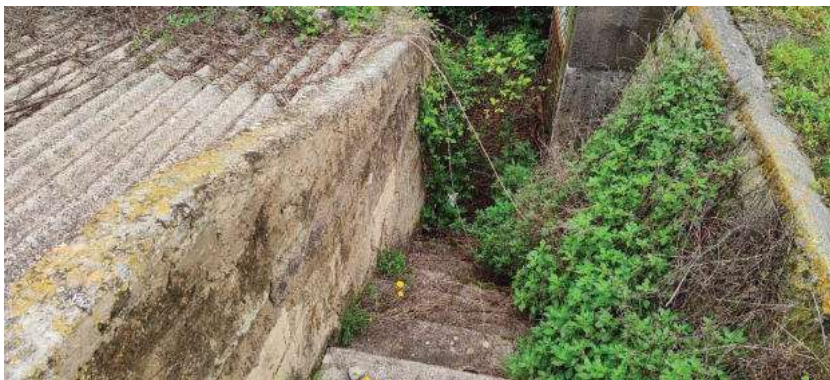
Foto 72 locale vasca plla 237
