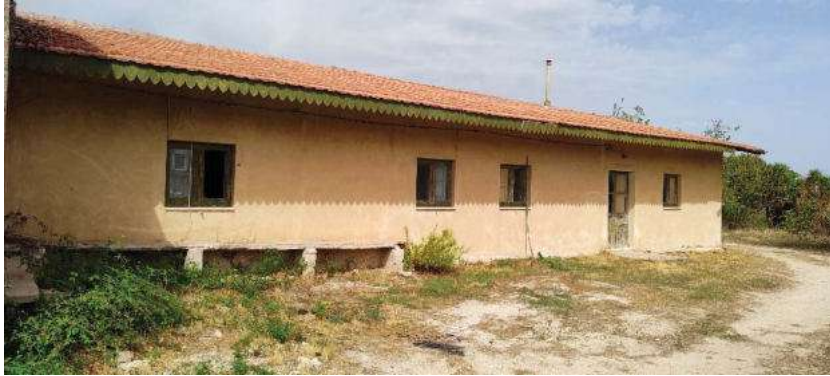
Foto 49 facciata sud casa custode
