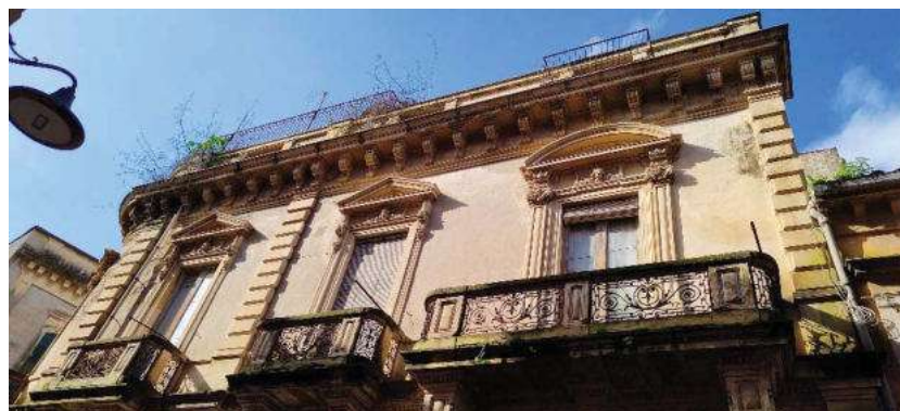
Foto 19: facciata lato Est
