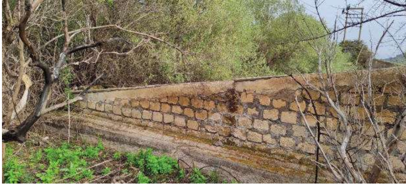
Foto 70 locale vasca plla 237
