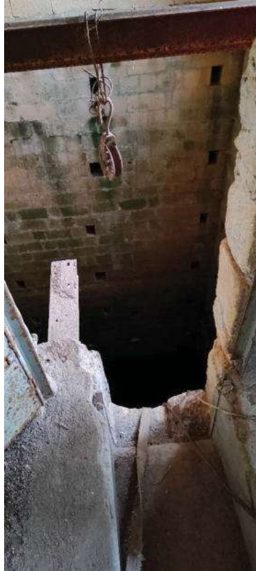
Figura 5: pozzo su p.lla 190
