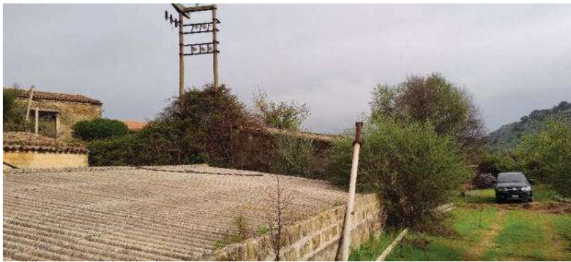
Foto 71 locale vasca plla 237
