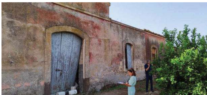
Foto 6: prospetto lato nord piano terra
