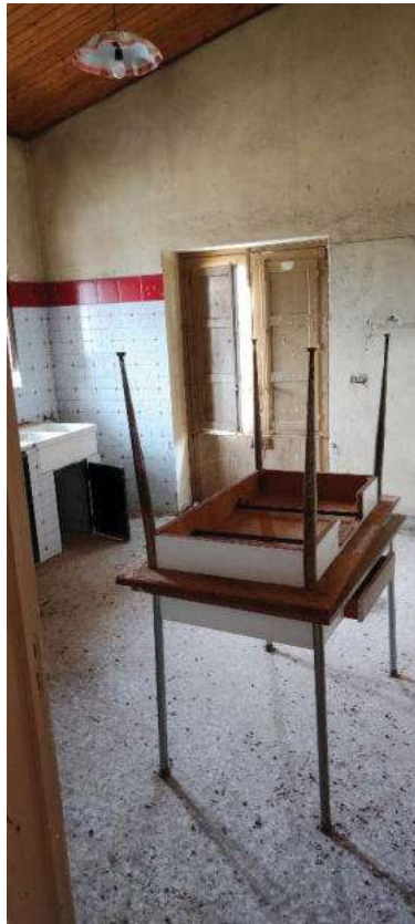
Foto 46 vano cucina casa custode
