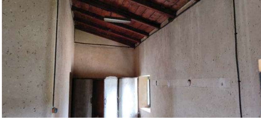
Foto 64 servizi per gli operai
