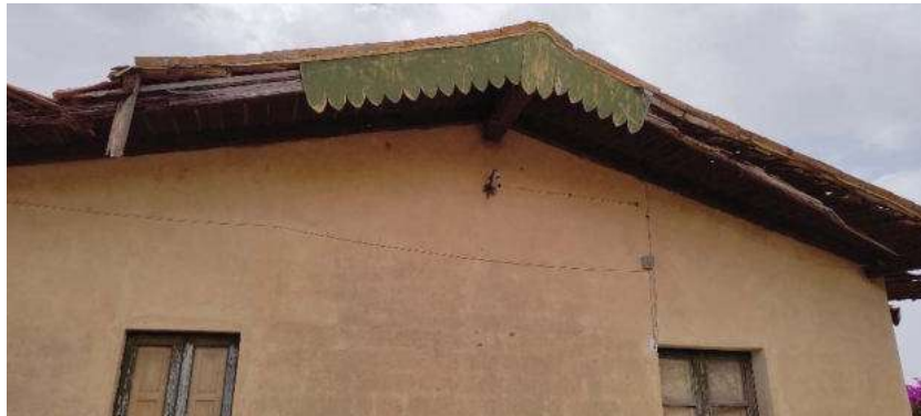
Foto 48 facciata Est casa custode
