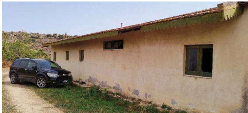
Foto 59 lato nord casa custode
