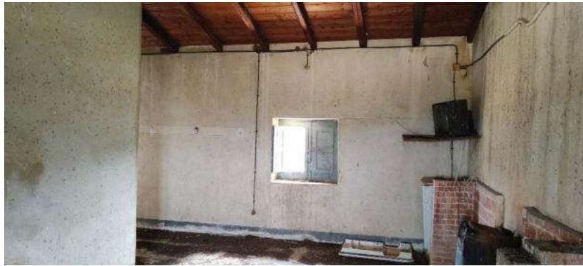
Foto 62 servizi per gli operai
