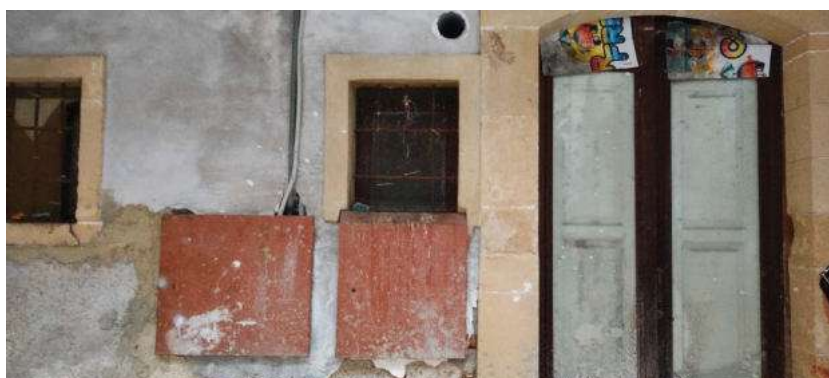
Foto 25: ingresso cortile vano secondario
