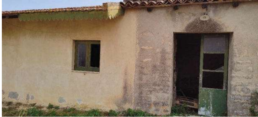
Foto 58 lato nord casa custode
