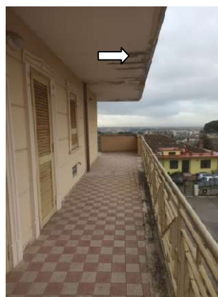
Dettaglio soffitti e frontalmi dei balconi
