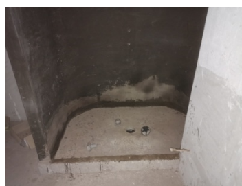
Vano doccia wc
