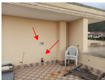
Predisposizione wc in terrazza
