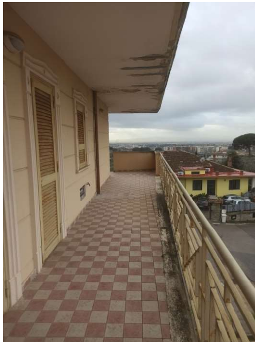
Balcone angolo sud-ovest
