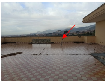
Predisposizione climatizzatori
