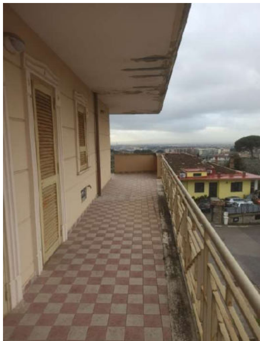
BALCONE LATO OVEST
