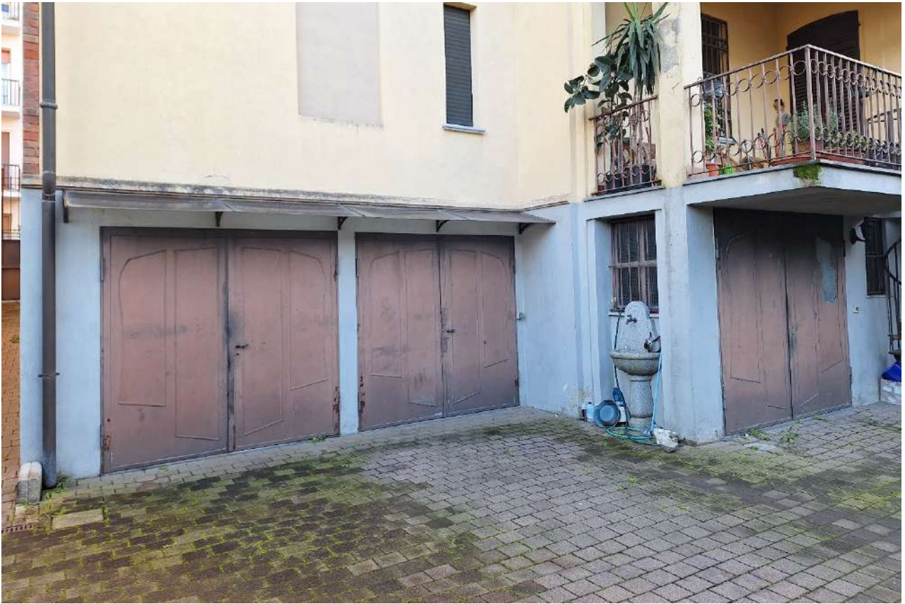
Vista degli accessi alle autorimesse (i due portoni a destra del sub. 9, il portone a sinistra del sub. 10).
