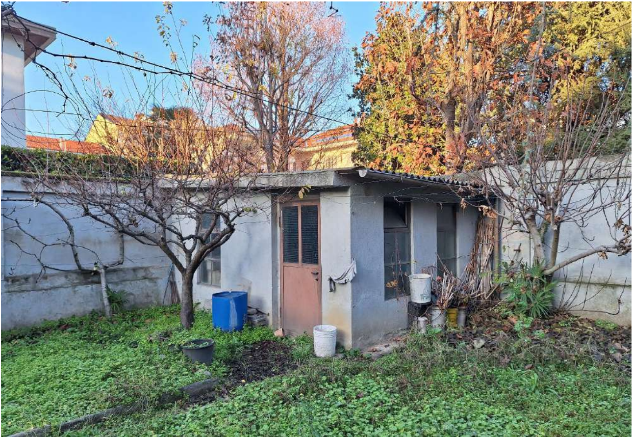
Vista del basso fabbricato posto all'angolo nord del giardino comune.
