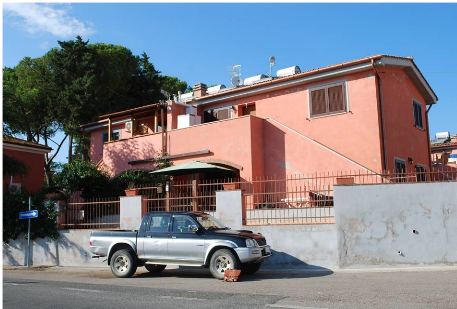
1. Veduta di insieme del fabbricato dalla S.P. n. 159 Scansanese (lato sud)
