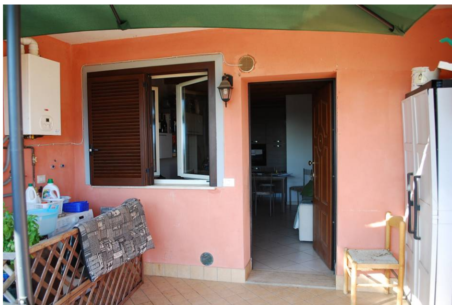
4. Veduta del portico di ingresso
