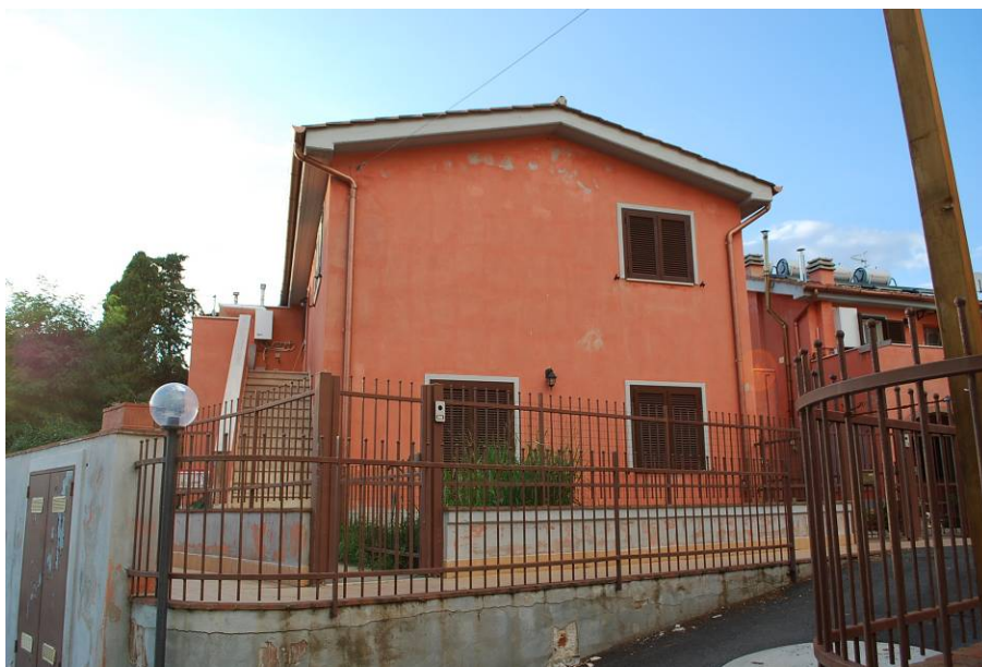
2. Veduta di insieme del fabbricato (lato est)
