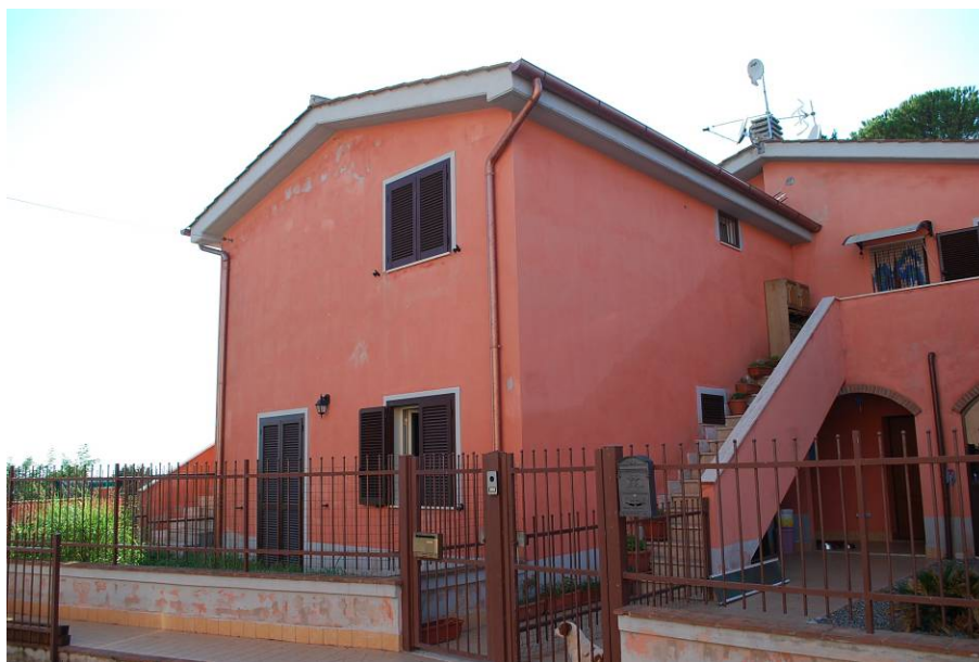
3. Veduta di insieme del fabbricato (lato nord-est)
