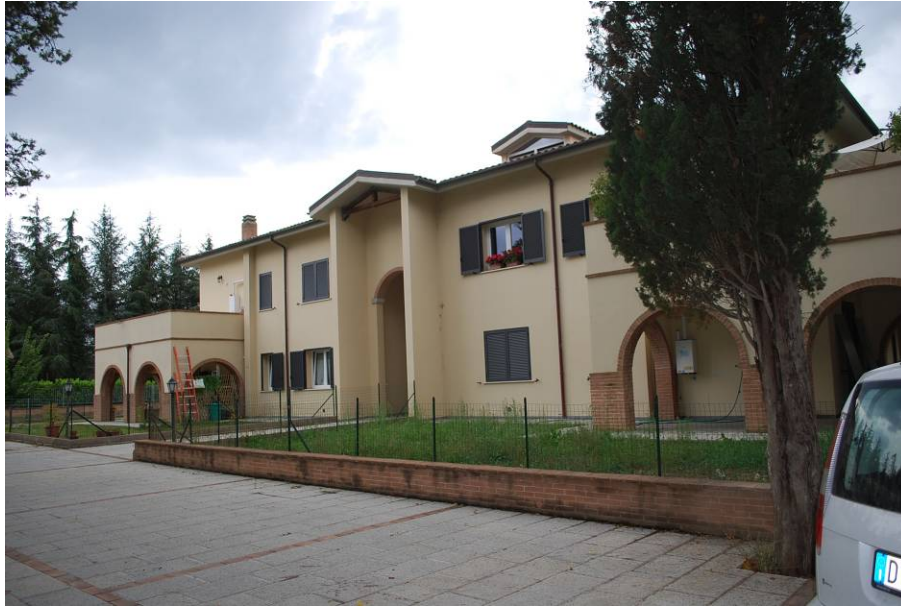
3. Veduta di insieme del fabbricato
