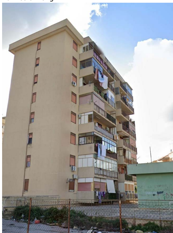
Foto 19 – prospetto su via Bartolomeo Sirillo
