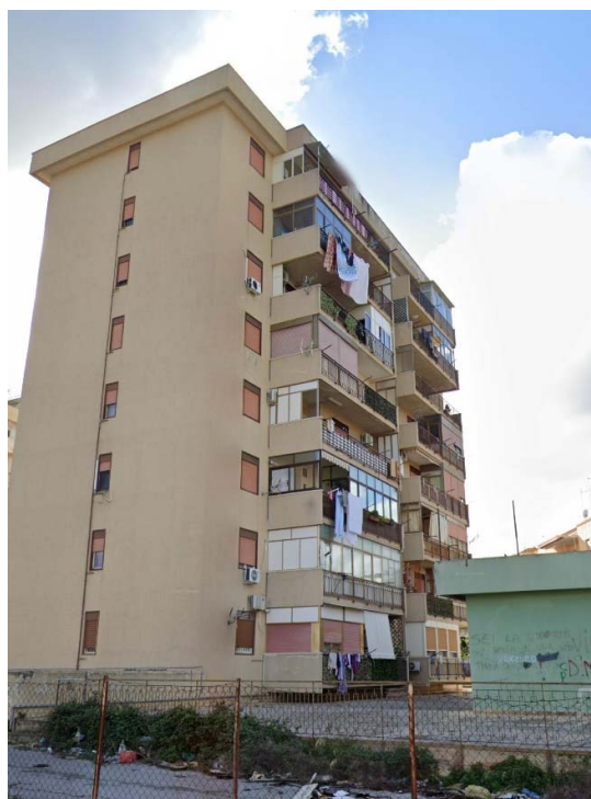
Foto 19 – prospetto su via Bartolomeo Sirillo
