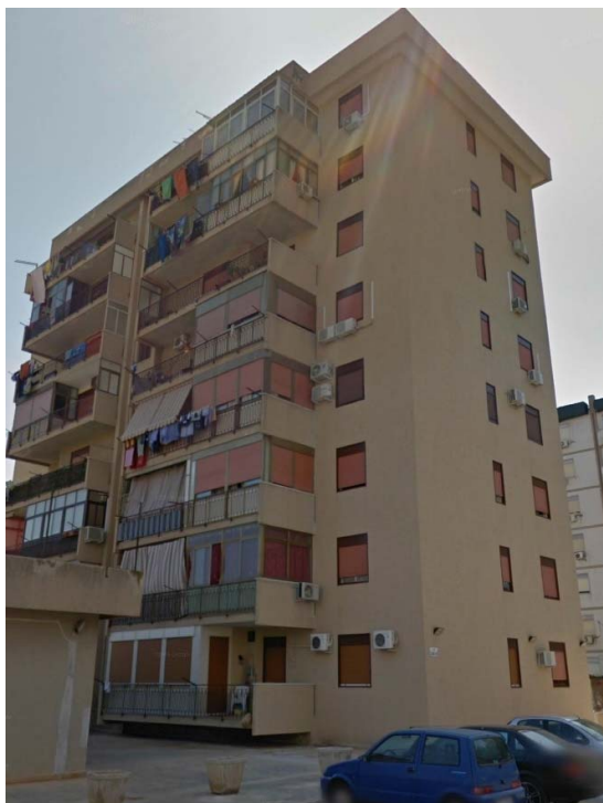
Foto 20 - prospetto su via Bartolomeo Sirillo
