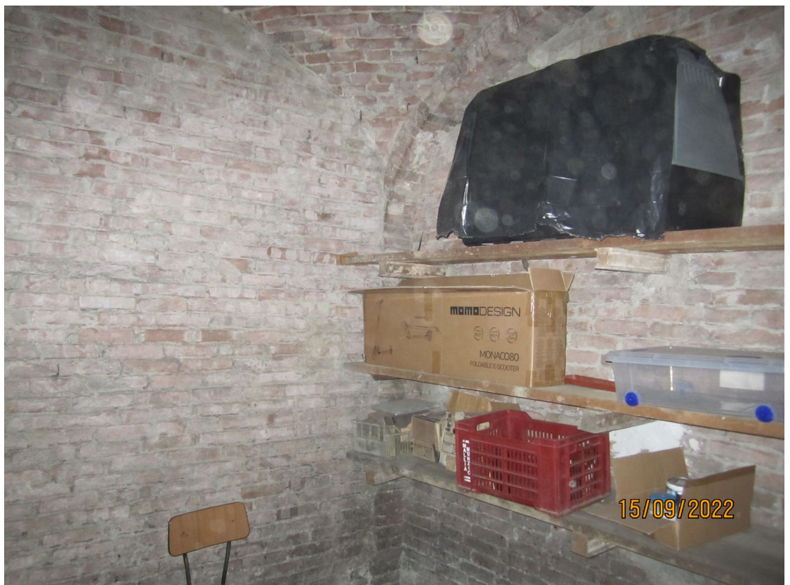
FOTO 18 Scorcio del locale cantina, di buona metratura, caratterizzato da muri e volta in mattoni a vista.
