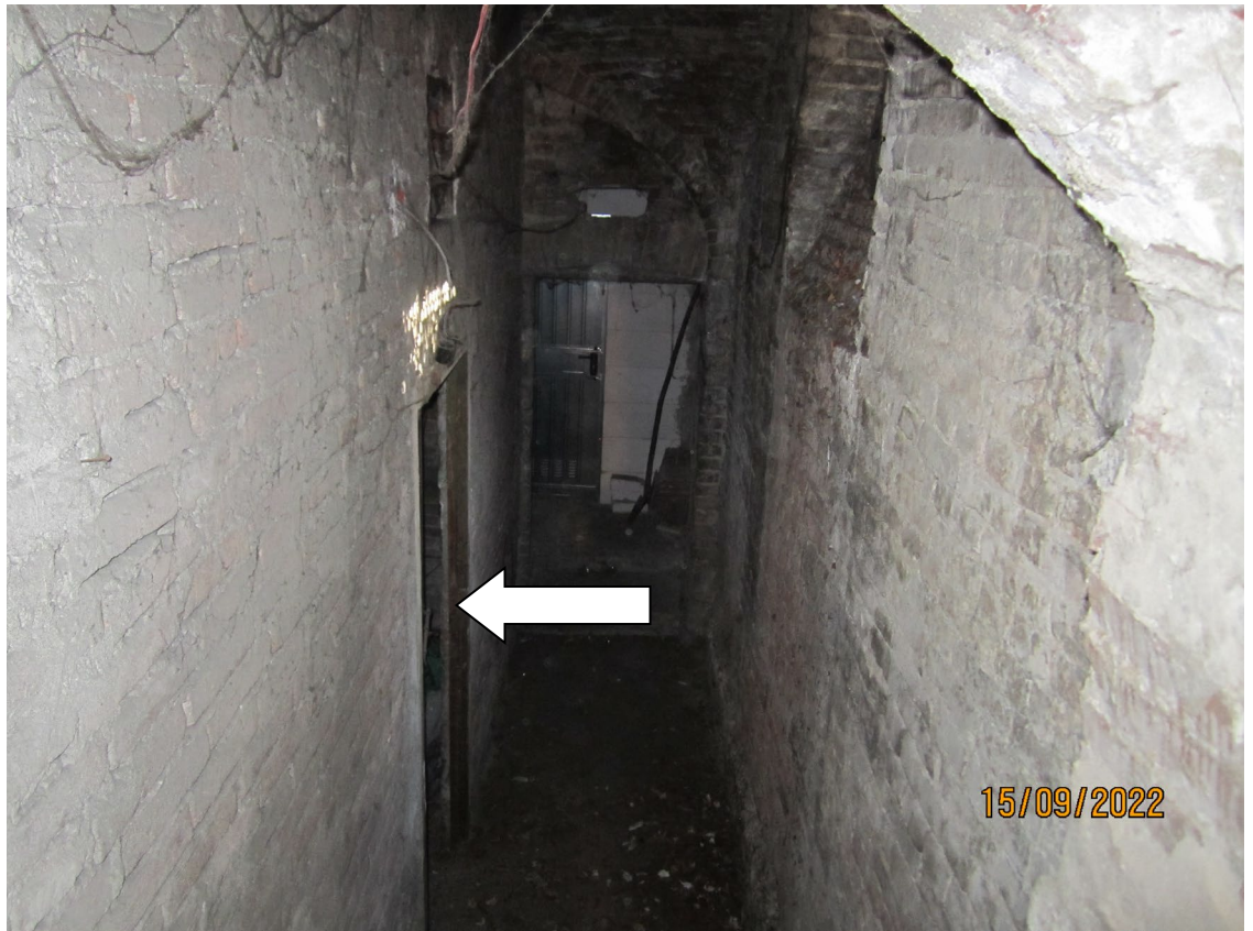
FOTO 17 Il disimpegno comune che da' accesso al locale cantina, al piano interrato del condominio.
