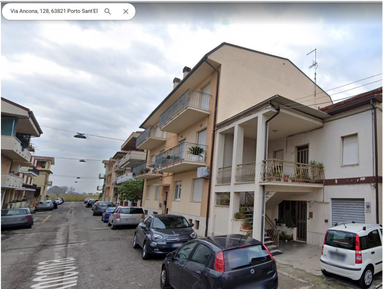
Porto Sant' Elpidio via Ancona n.128
