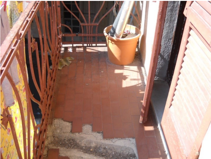
Balcone piano primo (lato cortile)
