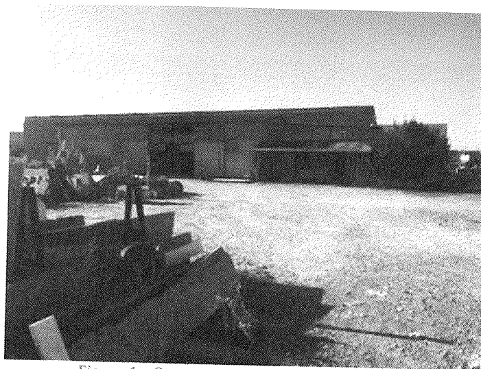
Figure 1 - Capannone oggetto di integrazione
