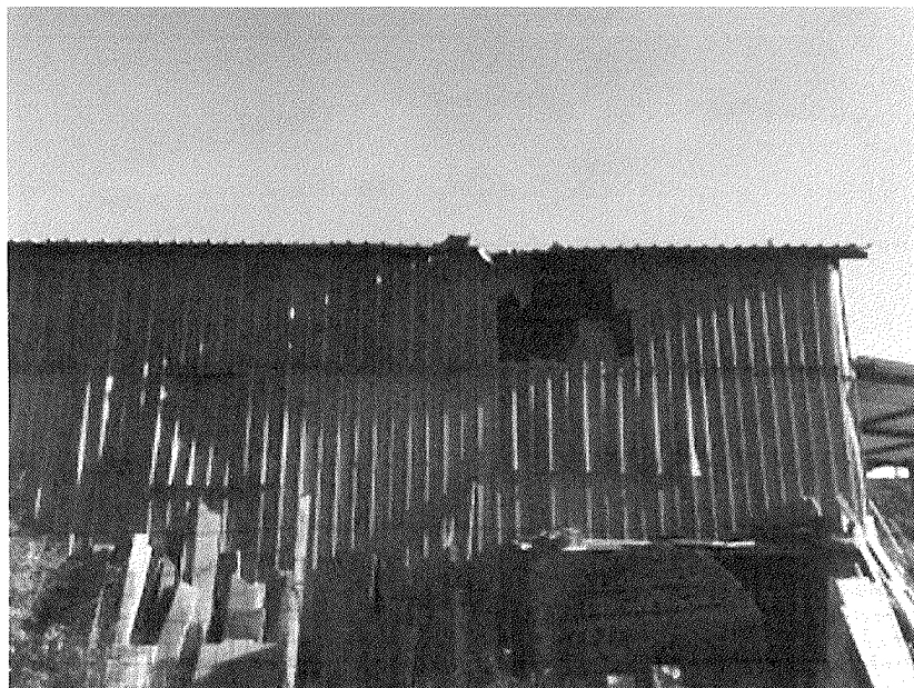
Figure 4 - vista retro officina
