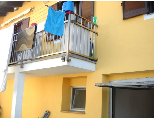
Balcone e finestra seminterrato abusivi
