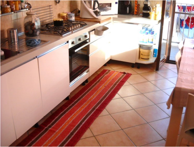
Cucina con porta finestra abusiva
