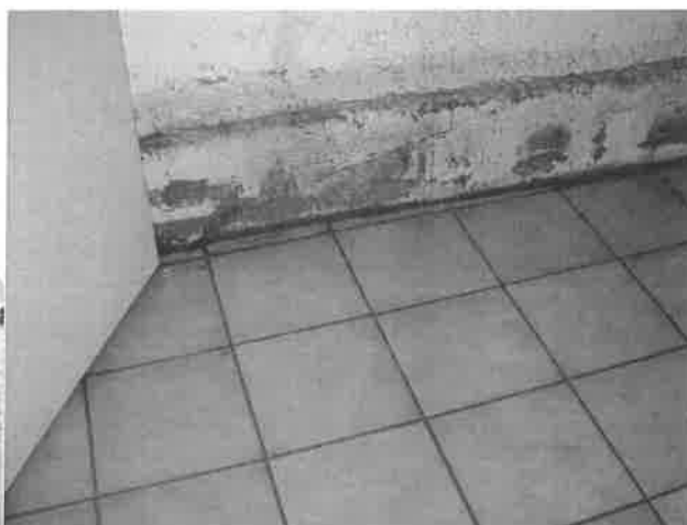
Muratura lato nord al piano seminterrato
