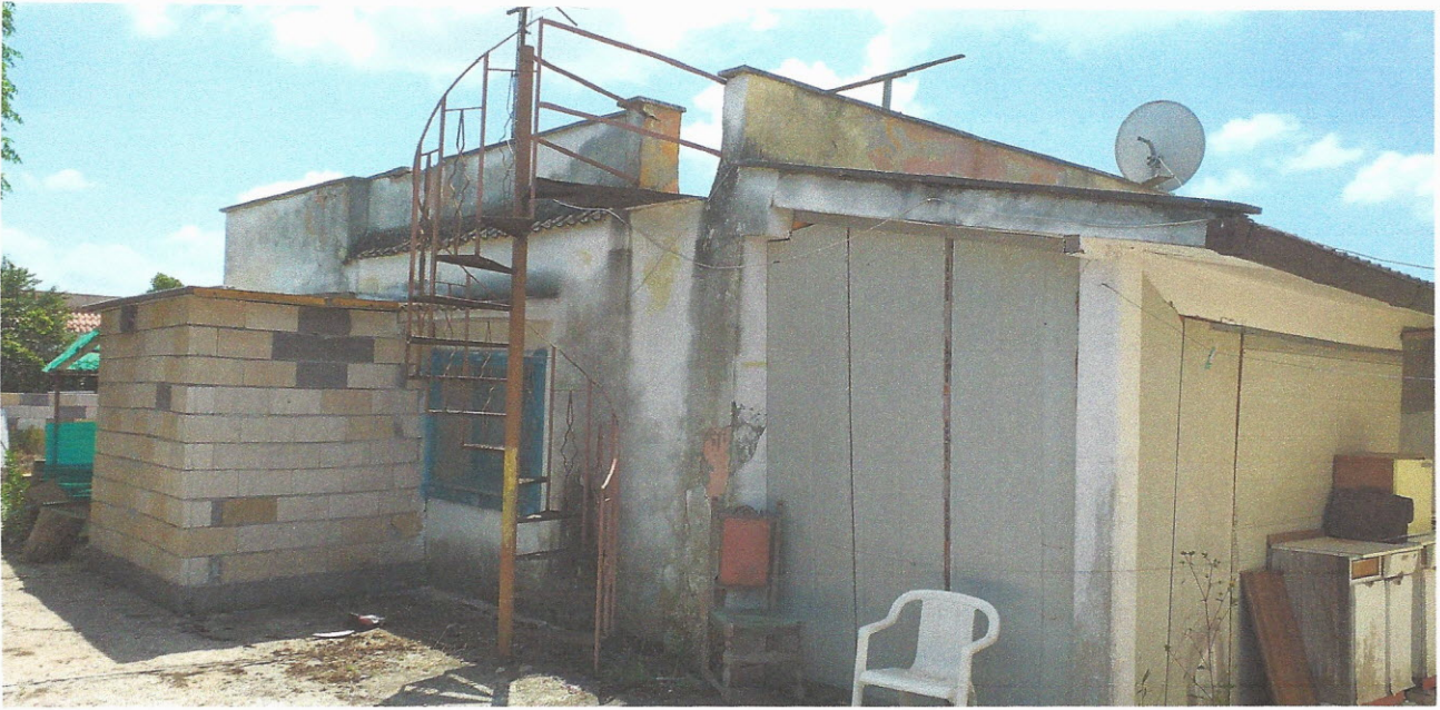
Foto 5. Prospetto frontale fabbricato Rif.1
