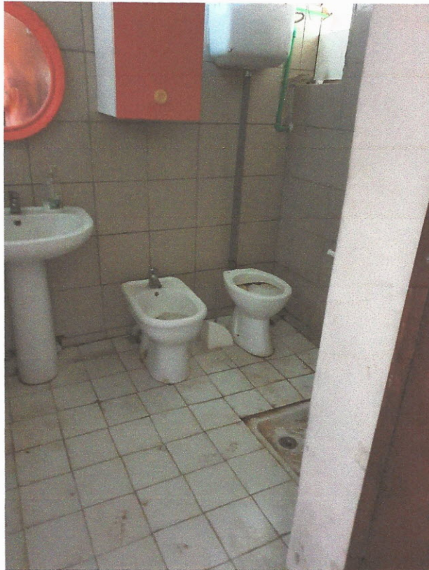
Foto 13. Fabbricato Rif.1- SERVIZIO IGIENICO
