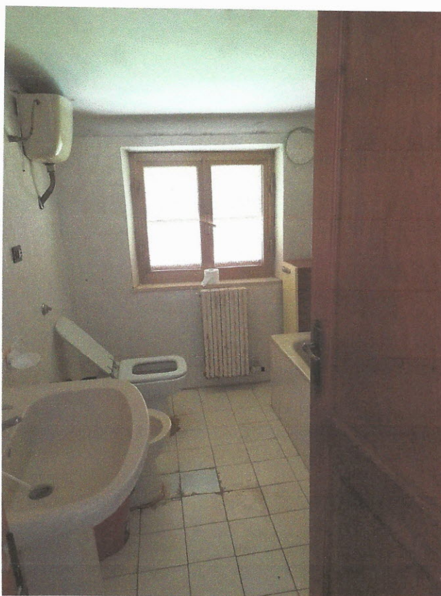
Foto 18. Fabbricato Rif.2 Servizio Igienico
