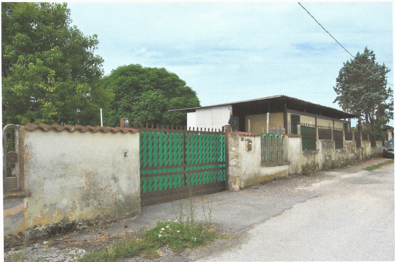
Foto 2. Ingresso Fabbricato Rif.1
