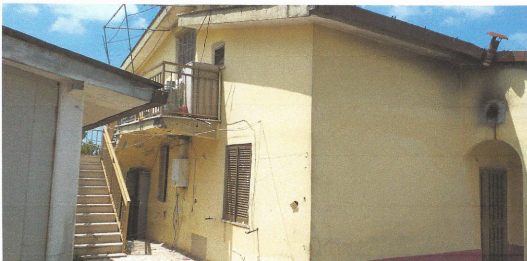
Foto 16. Fabbricato Rif.2 Scala di accesso
