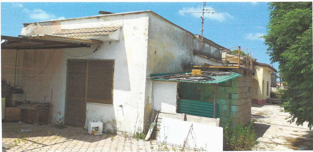
Foto 4. Ingresso fabbricato Rif.1
