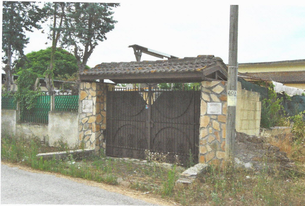
Foto 14. Ingresso Fabbricato Rif.2
