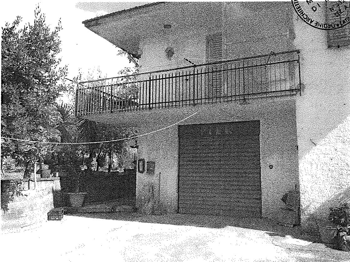
Foto 4 – Particolare vista fronte nord-ovest
