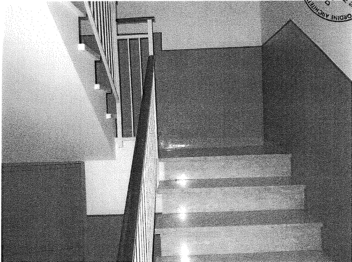
Foto 14 – Corpo scala interno
