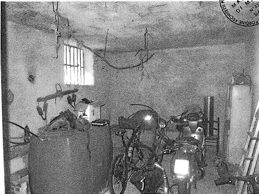
Foto 8 – Vista ulteriore deposito piano terra
