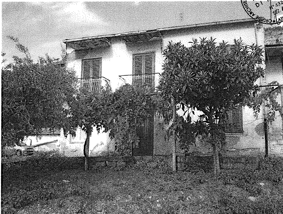
Foto 2 – Particolare fronte sud-ovest con ingresso appartamento distinto al sub 2 via dell'Acquedotto Paolo, 163, 00168 Roma (RM) – tel. 0689563114 - via Liguria, 3, 04019 Terracina (LT) cell. 3398061151 – e-mail: mauriziodimario@yahoo.it C.F. DMR MRZ 61M27H501P – P.I. 01224050599
