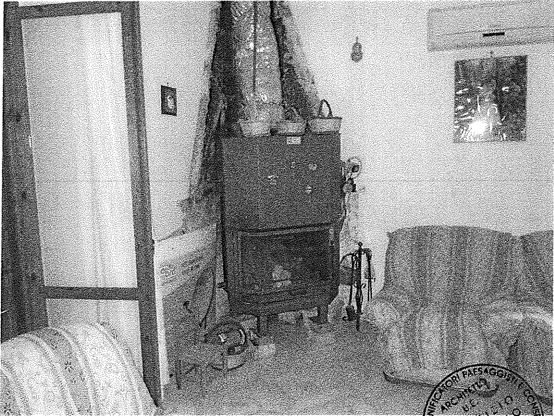
Foto 7 – Particolare termocamino nel soggiorno
