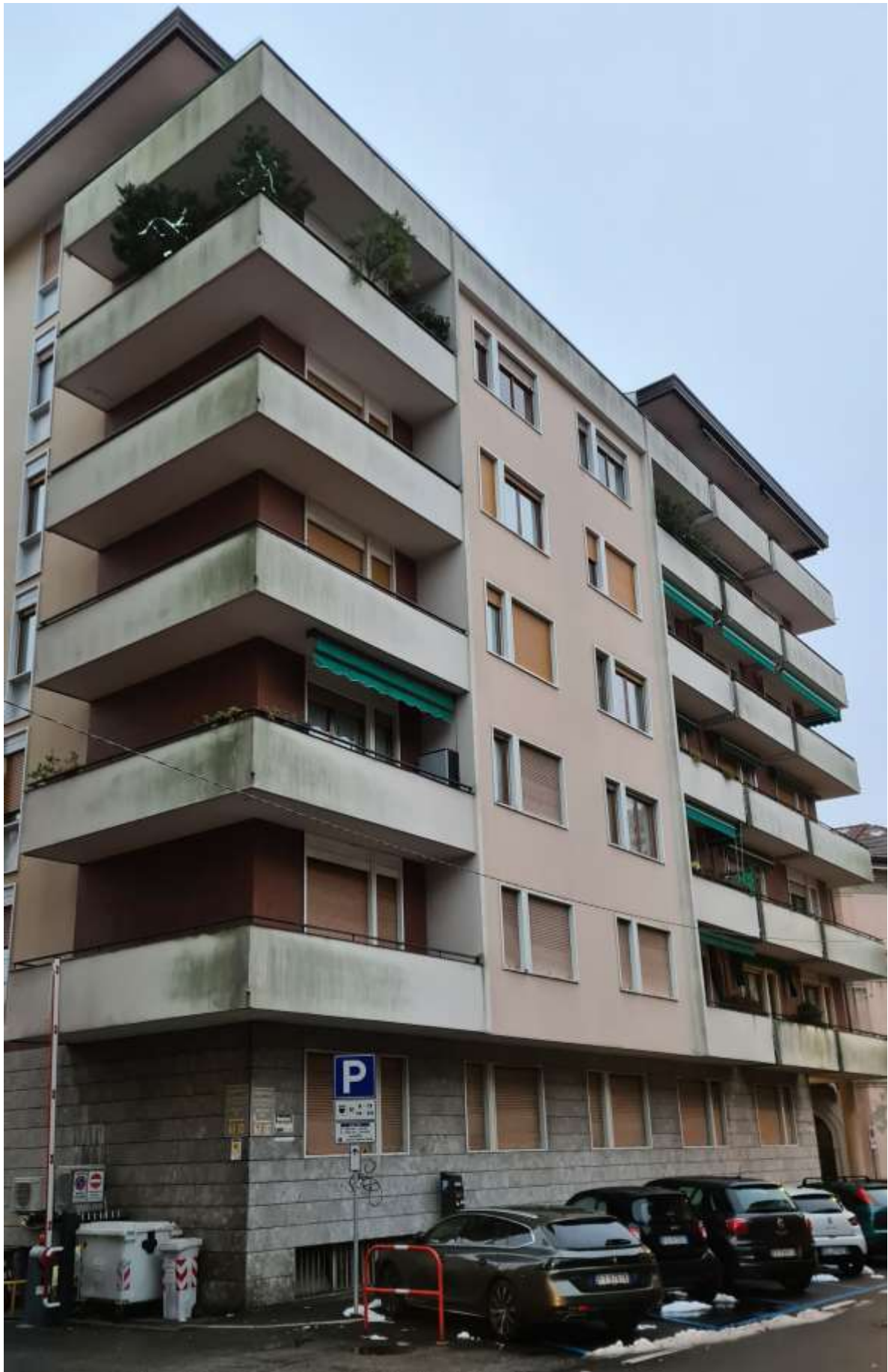
FOTO 2) Particolare del fronte su Via Grandi
