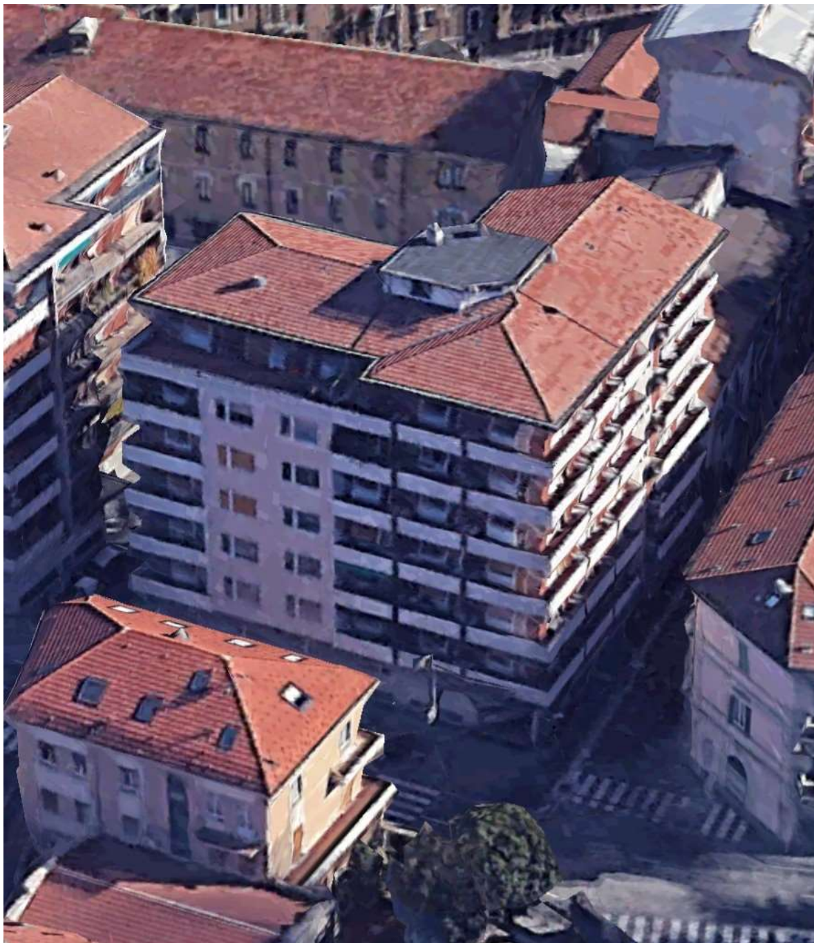
FOTO 1) Vista aerea del Condominio
