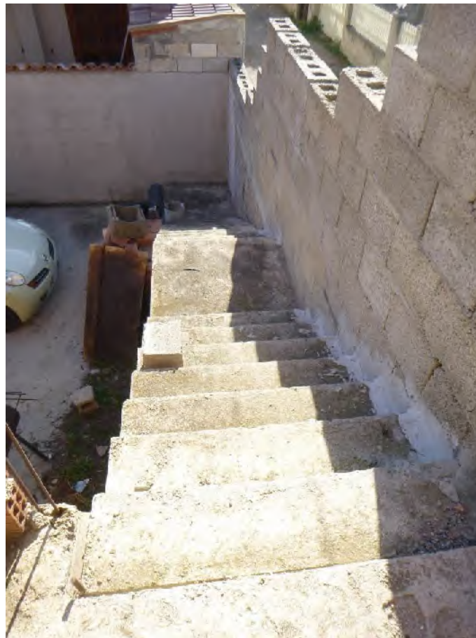
Foto 4.: scala di accesso al piano primo
