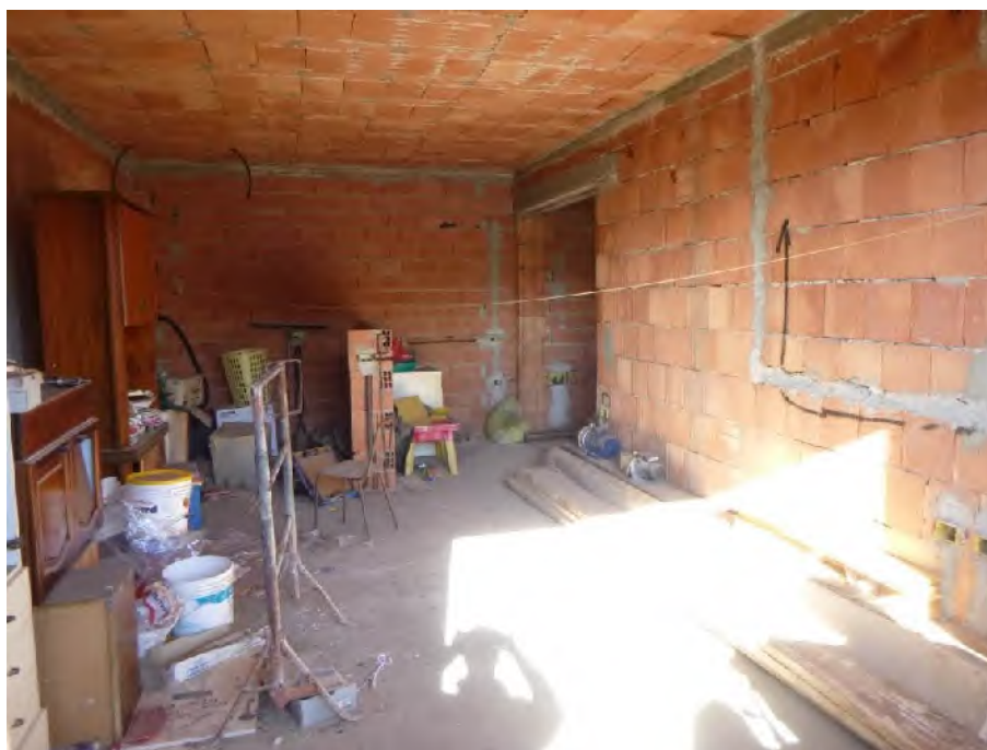
Foto 6.: stato attuale di avanzamento dei lavori piano primo
