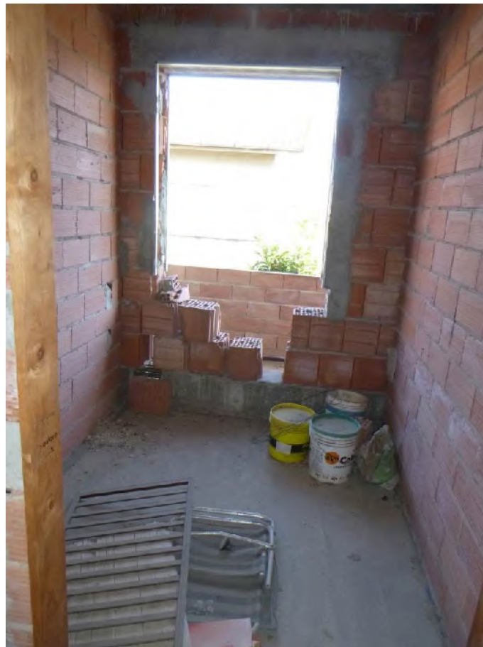
Foto 14.: finestra lato sud
