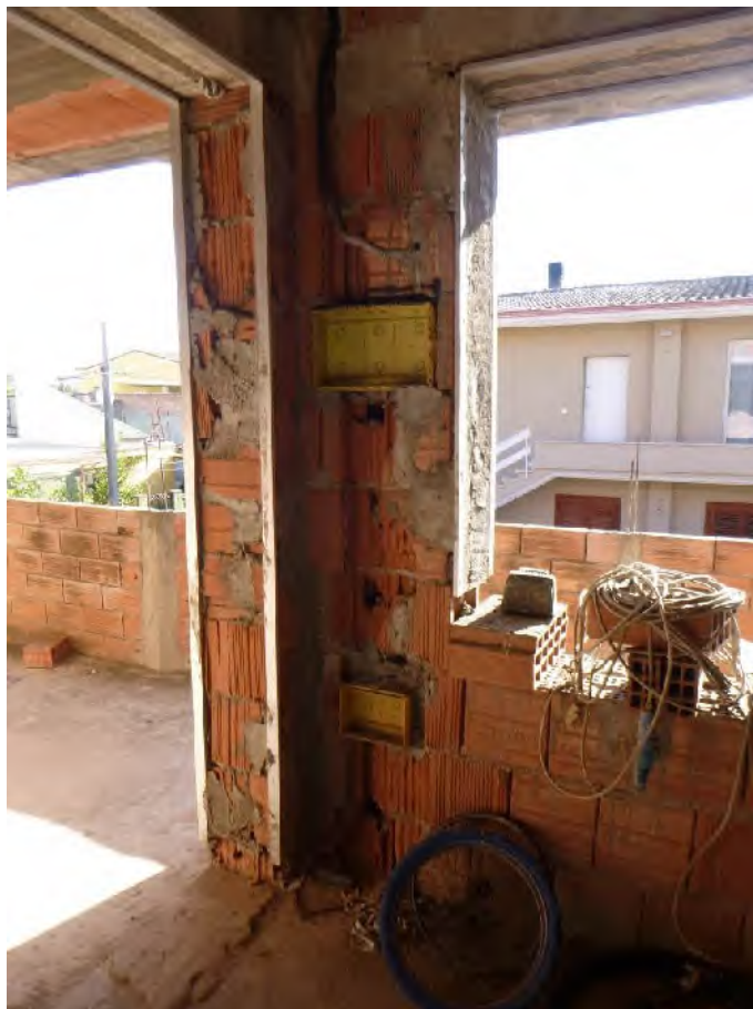
Foto 5.: finestra e accesso piano primo
