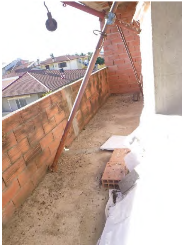
Foto 10.: balcone lato Ovest
