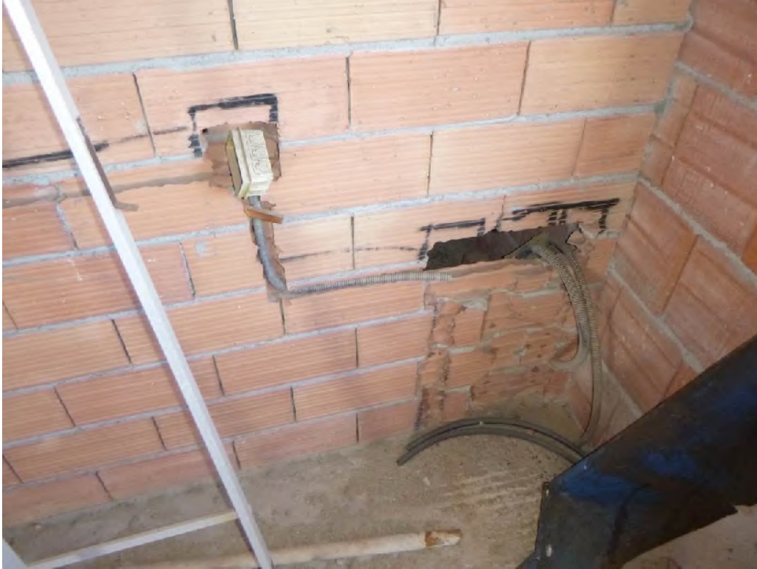
Foto 7.: Posa corrugati per impianto elettrico
