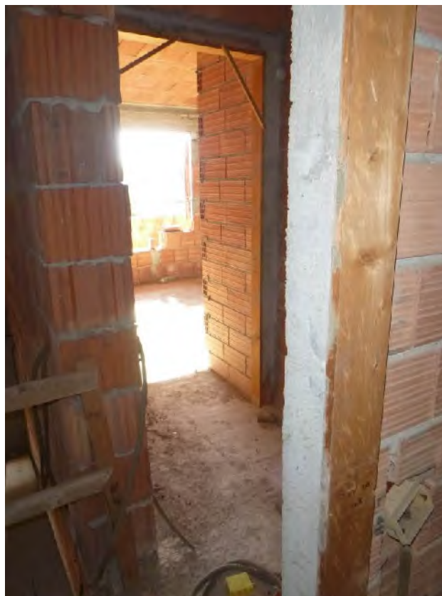
Foto 12.: stato attuale avanzamento lavori piano secondo
