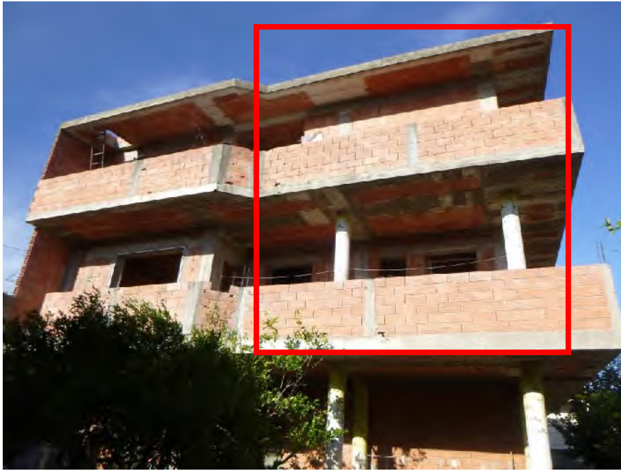
Foto 3.: Prospetto lato Ovest: si noti l'inversione dell'ingombro fra piano primo e secondo
