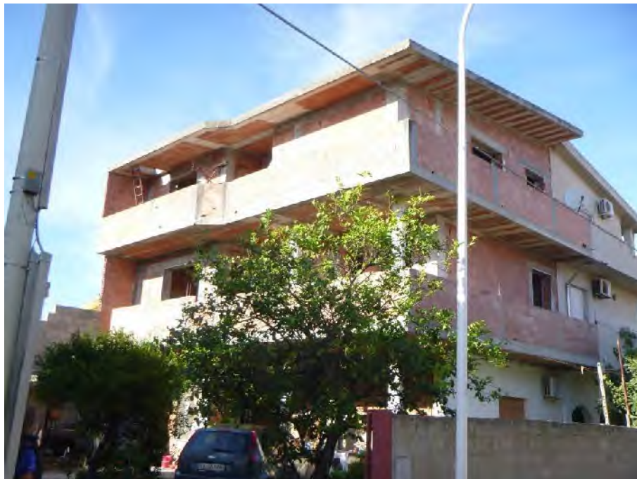
Foto 2.: Prospetti lato sud e Ovest: si noti l'inversione dell'ingombro fra piano primo e secondo.
