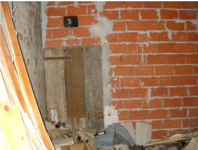
Locale cantina in piano seminterrato (sub.40)
