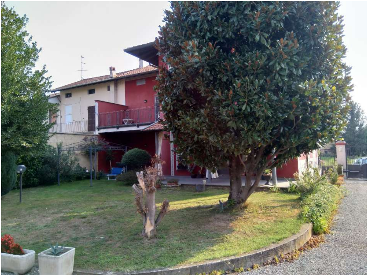
Fotografia n. 3: vista facciata ovest e area cortile e verde
