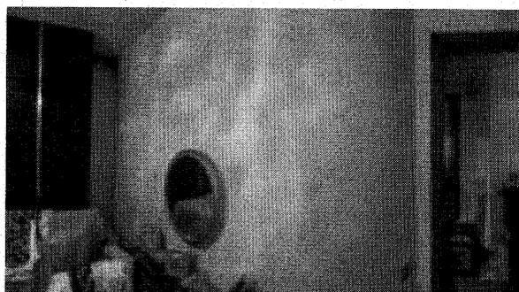
Foto n. 11 – Particolare muffa nella camera da letto e rientranza per vano scala a chiocciola
