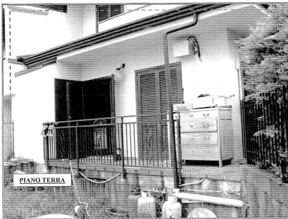
- Foto 3 (Vista esterna del Piano Terra) -
