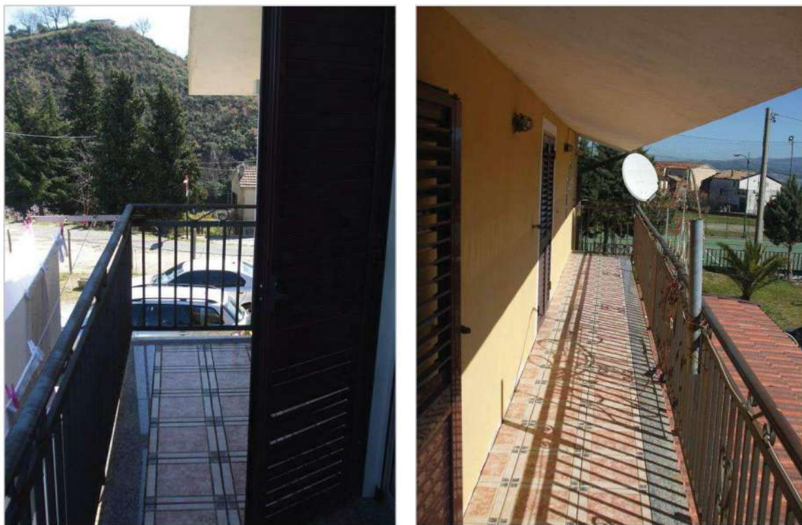
Foto 28 e 29 (esterni piano primo: balconi)
