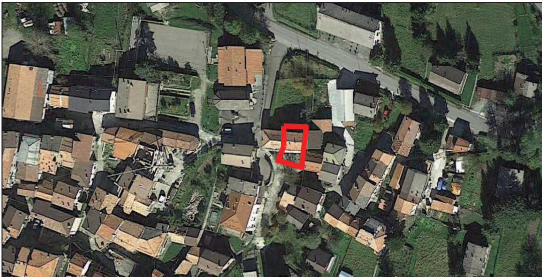
Individuazione su foto aerea dell'unità in oggetto
