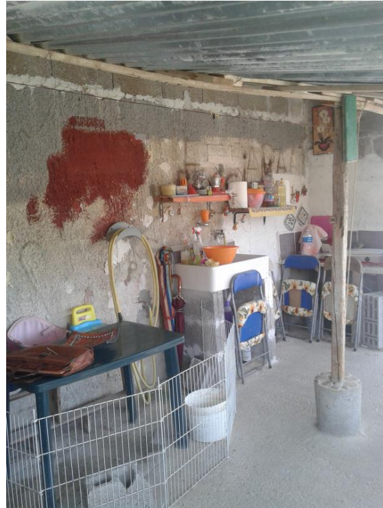
Foto 4: prospetto esterno con tettoia
