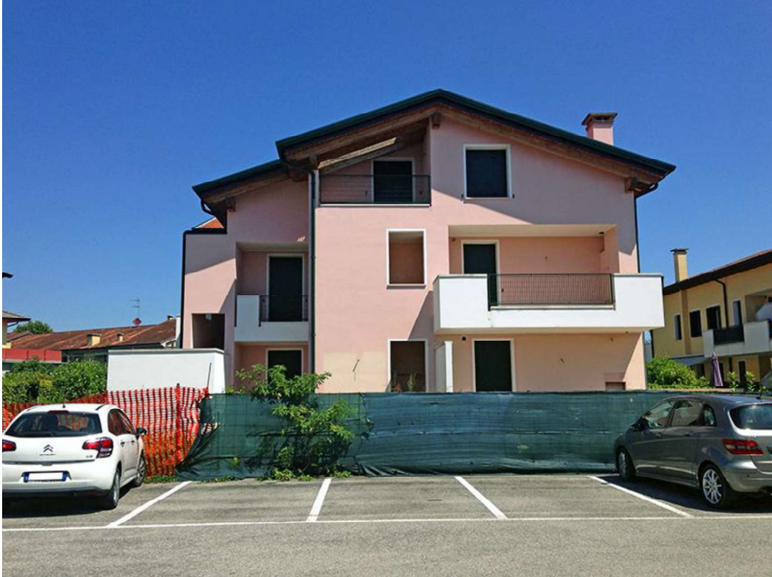
Condominio Glicine – Fronte su via Re Ashoka.
