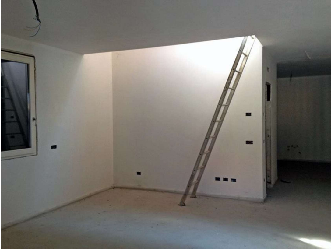
Condominio Glicine – P1 App.4 – Il vano principale senza scala al sottotetto.
