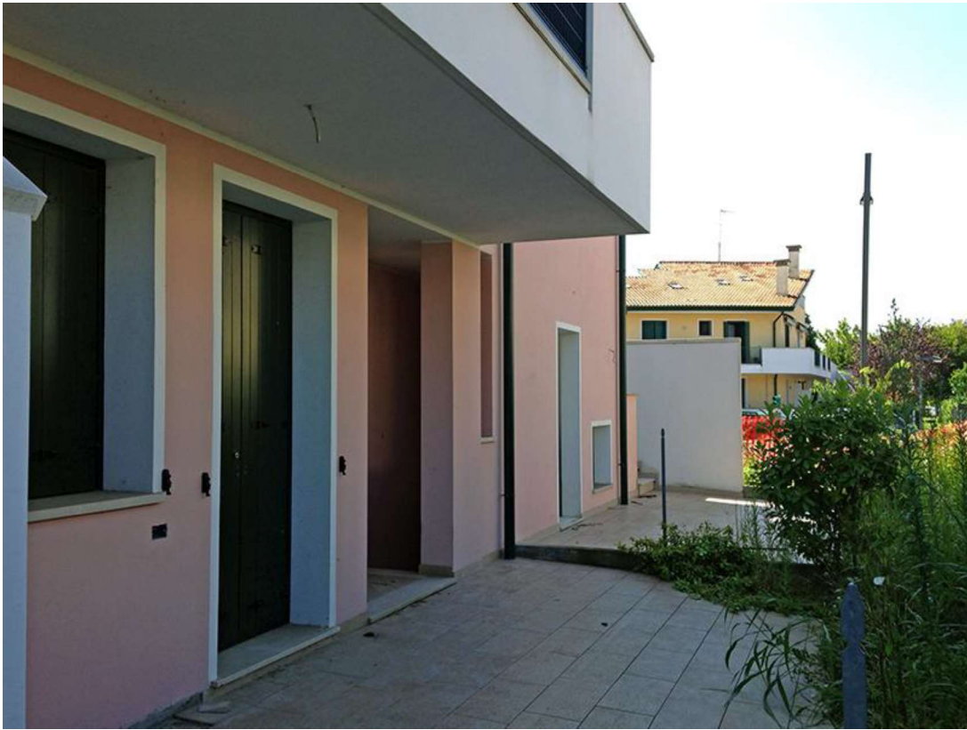
Condominio Glicine – Il piano terra sul prospetto nord.
