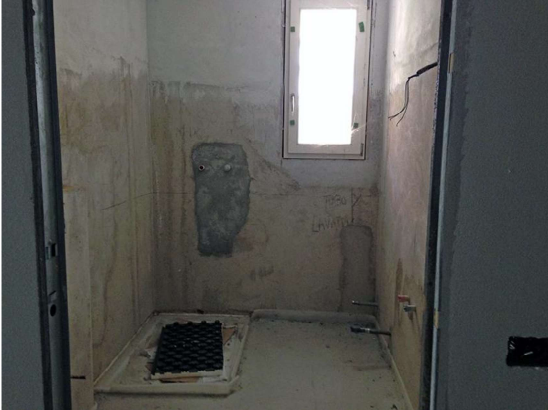
Condominio Glicine – PT App.4 – Il bagno al grezzo.
