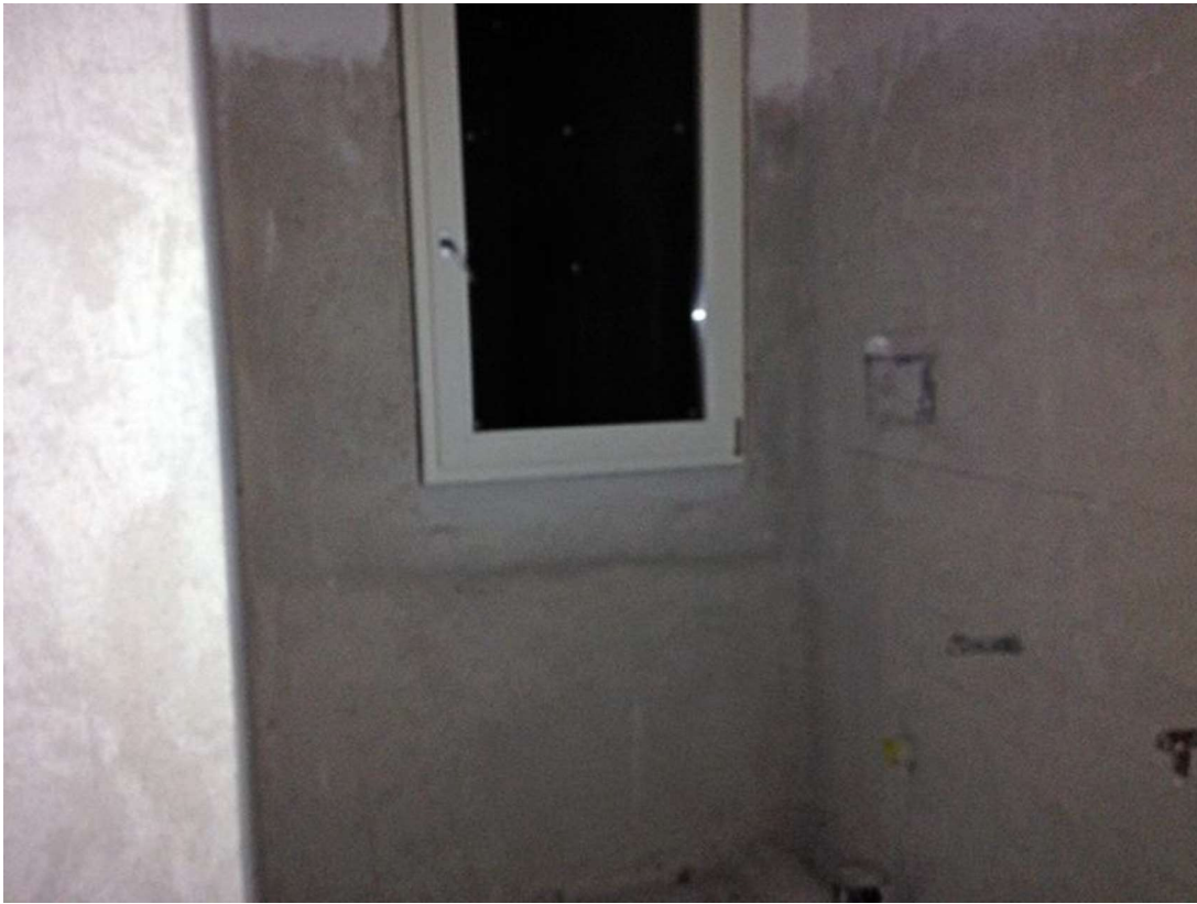
Condominio Glicine – PT App.3 – Il bagno al grezzo.
