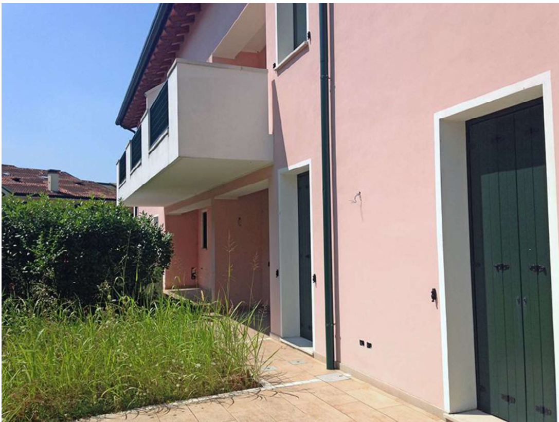
Condominio Glicine – Il piano terra sul prospetto sud.
