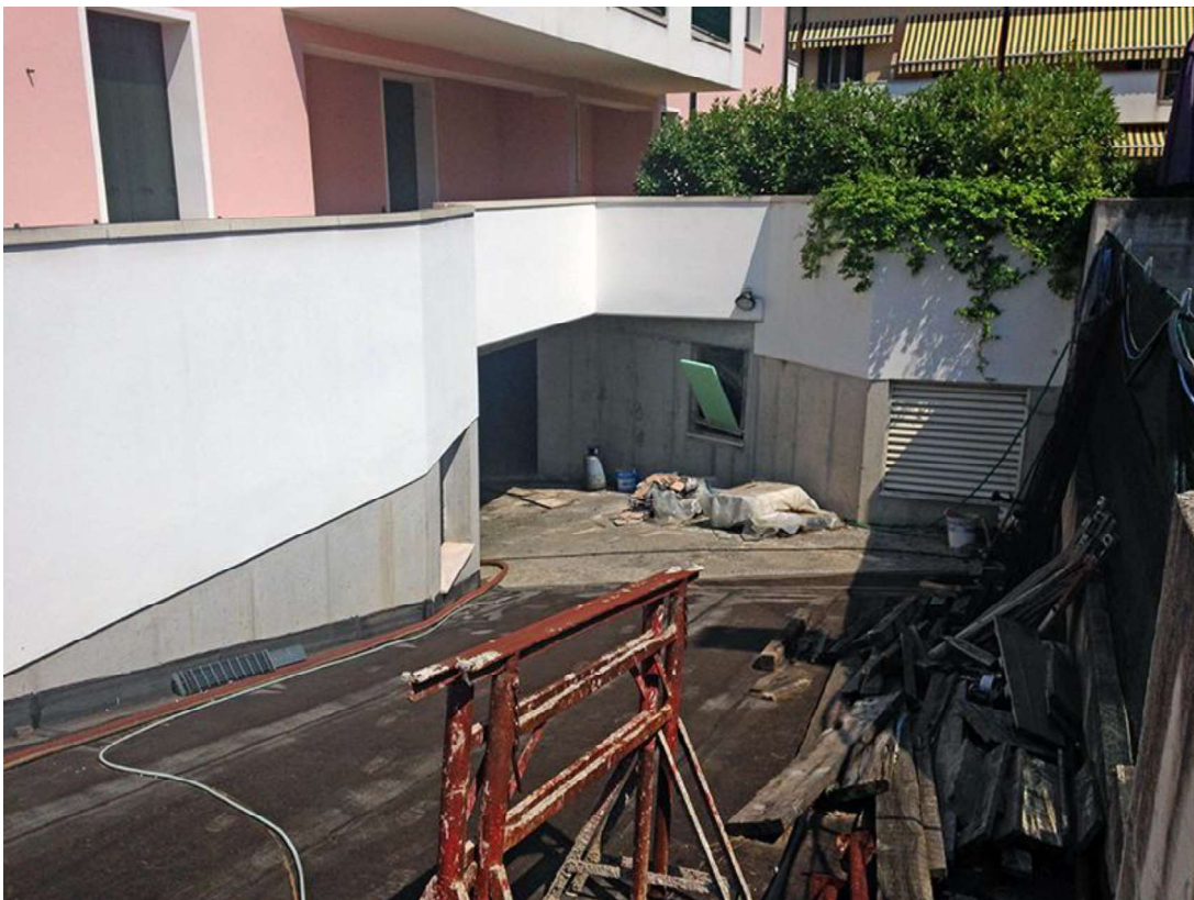
Condominio Glicine – La rampa di accesso ai box auto da via Re Ashoka.
