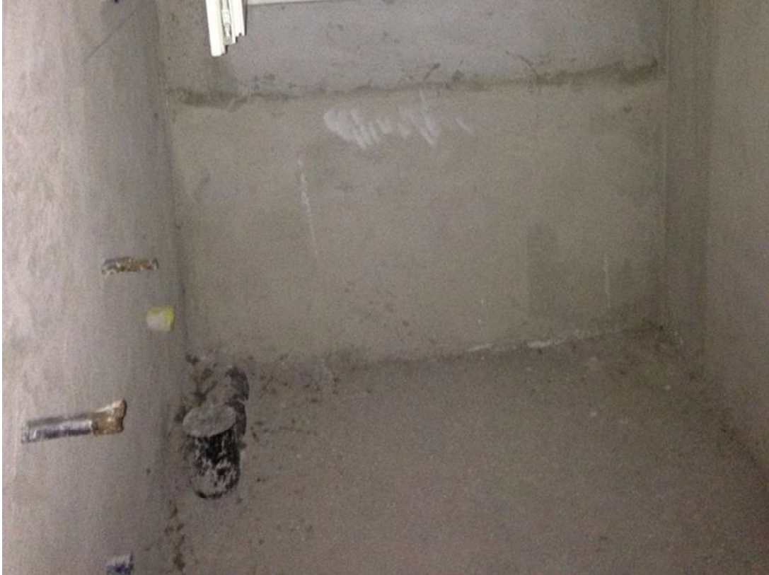
Condominio Glicine – PT App.2 – Il bagno al grezzo.
