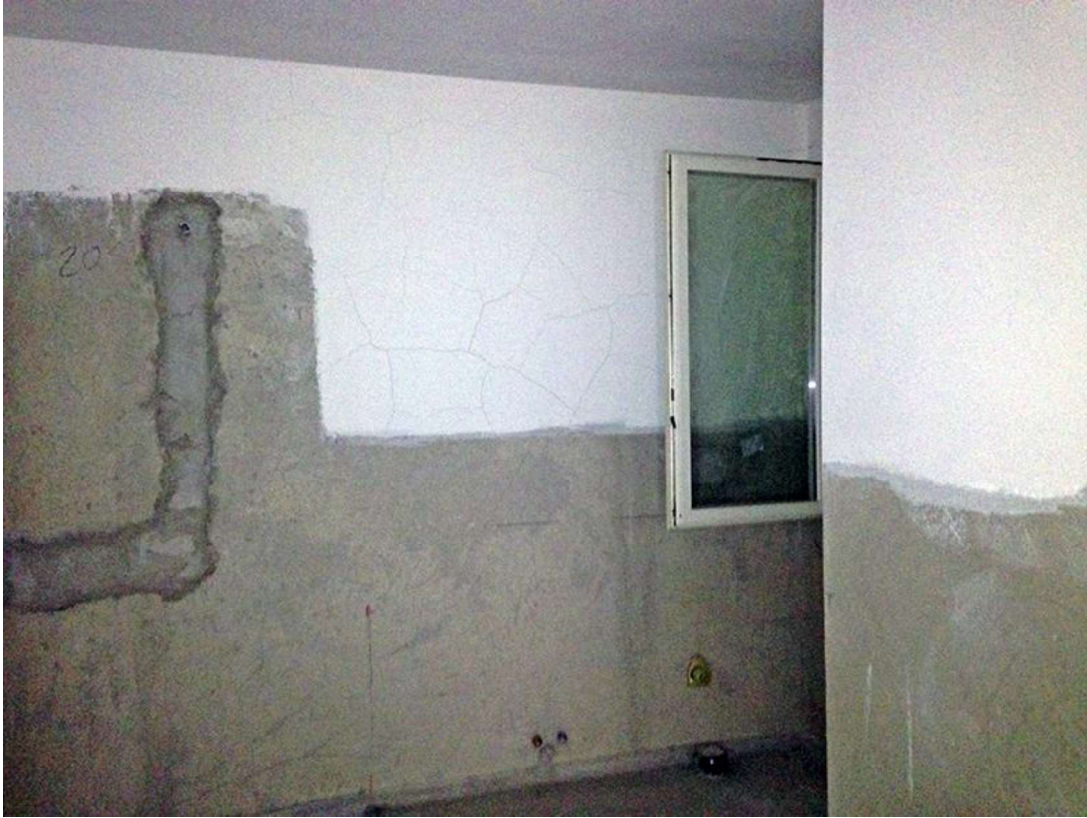
Condominio Glicine – P1 App.2 – Il bagno al grezzo.
