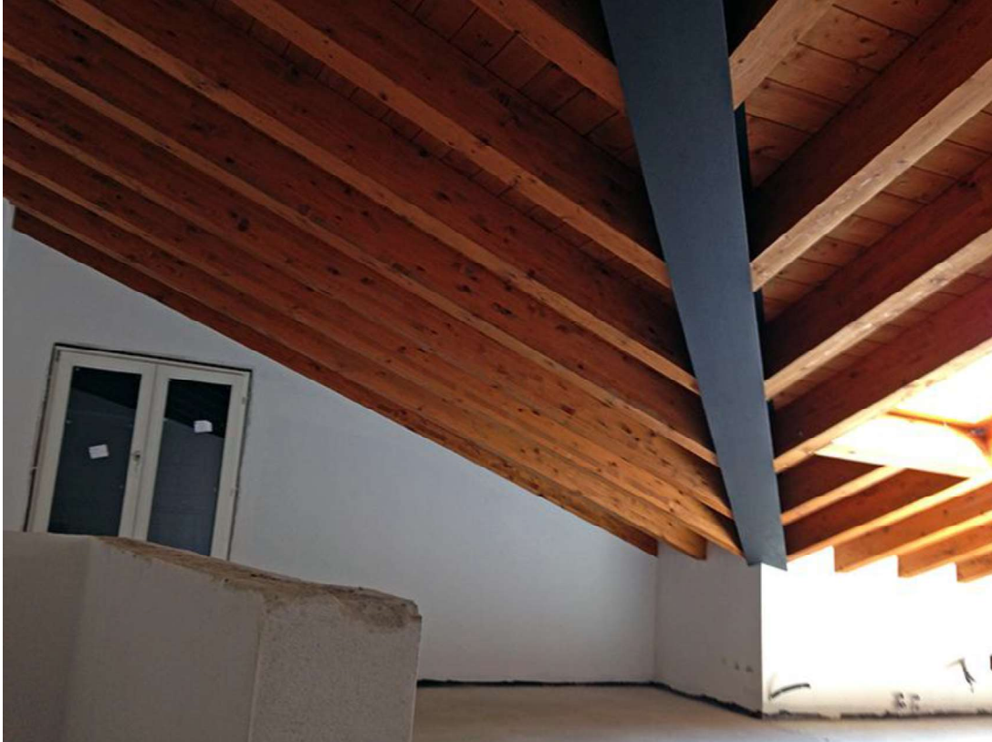
Condominio Glicine – P1 App.3 – Il particolare della trave in metallo.
