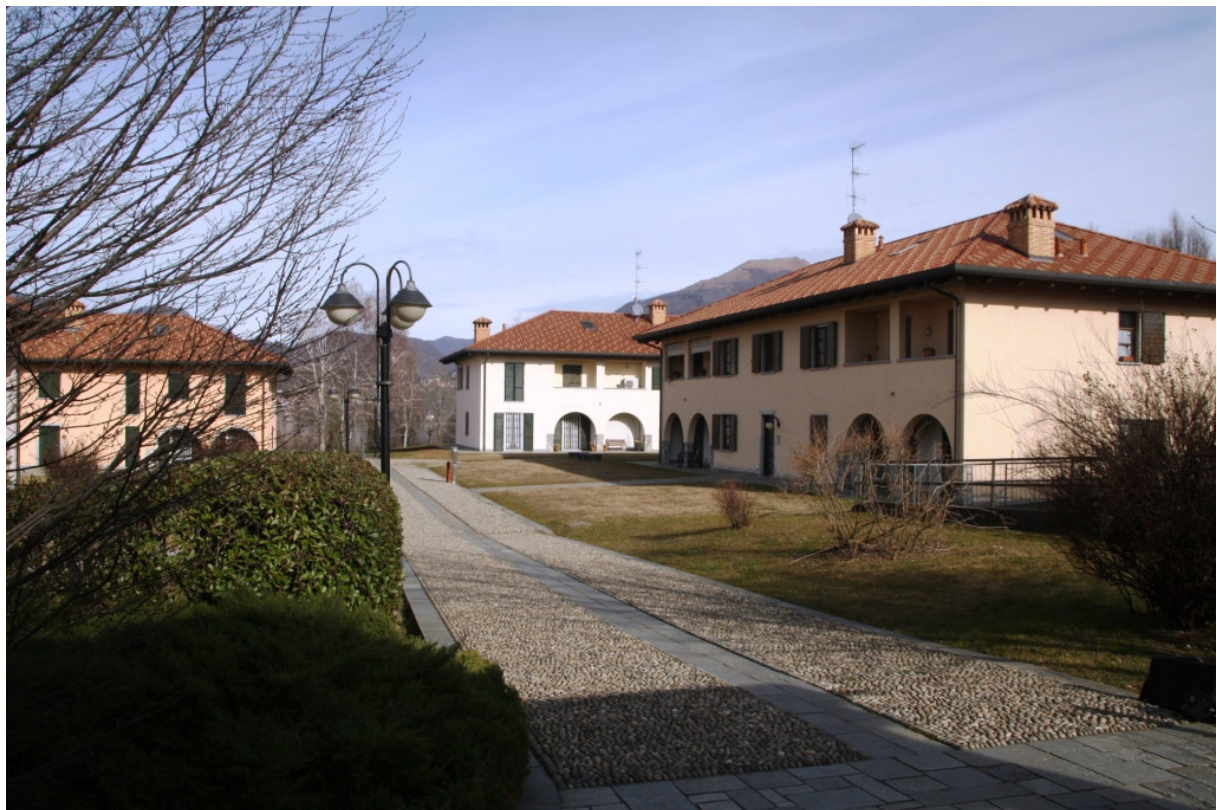
FOTO 2 - ESTERNO DEL COMPLESSO CONDOMINIALE "IL MANIERO"
