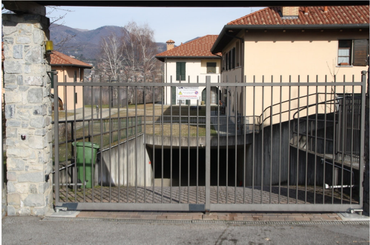
FOTO 3 - RAMPA DI ACCESSO CARRABILE AL PIANO INTERRATO DEL CONDOMINIO
