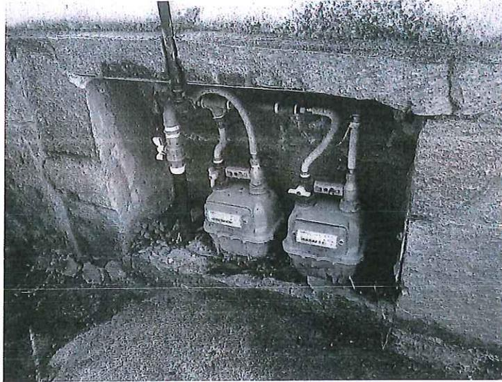
**foto 31 – Particolare Contatori Gas GPL - Esterno.**
