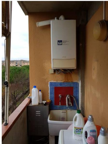
Non sono completamente note le caratteristiche della rete di distribuzione dell'impianto di riscaldamento in quanto lo stesso si sviluppa sotto traccia. Verosimilmente le tubazioni sono in multistrato, ma non è stato possibile stabilire il loro grado di coibentazione.
