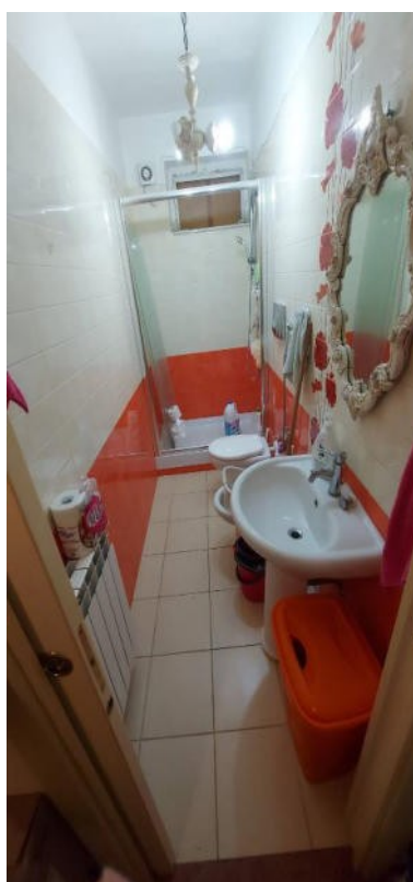
Foto 7 – piano terra – w.c.
