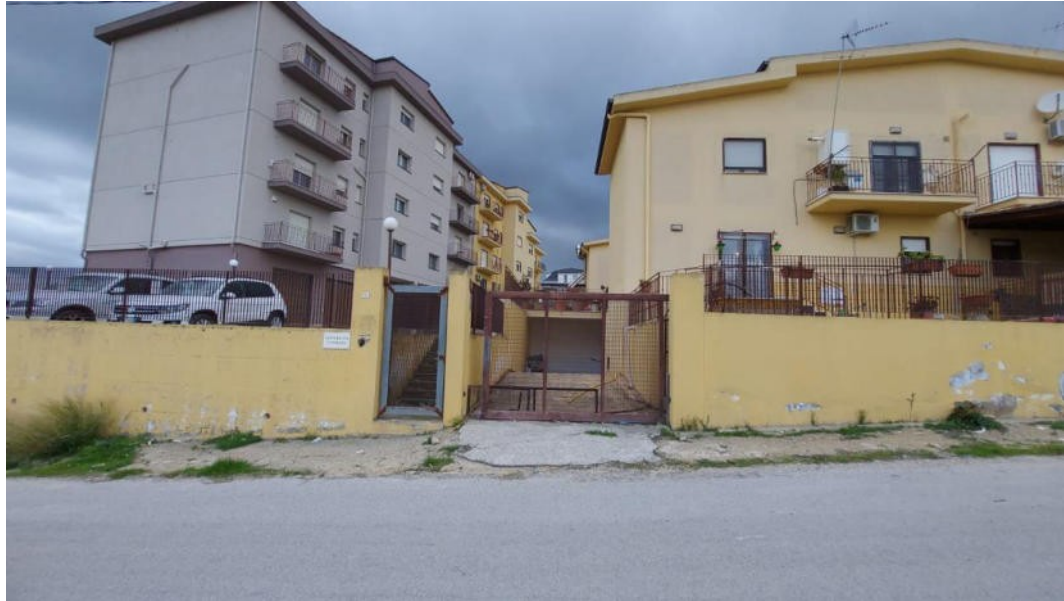
Foto 4 – prospetto sud est da via Antonio de Curtis
