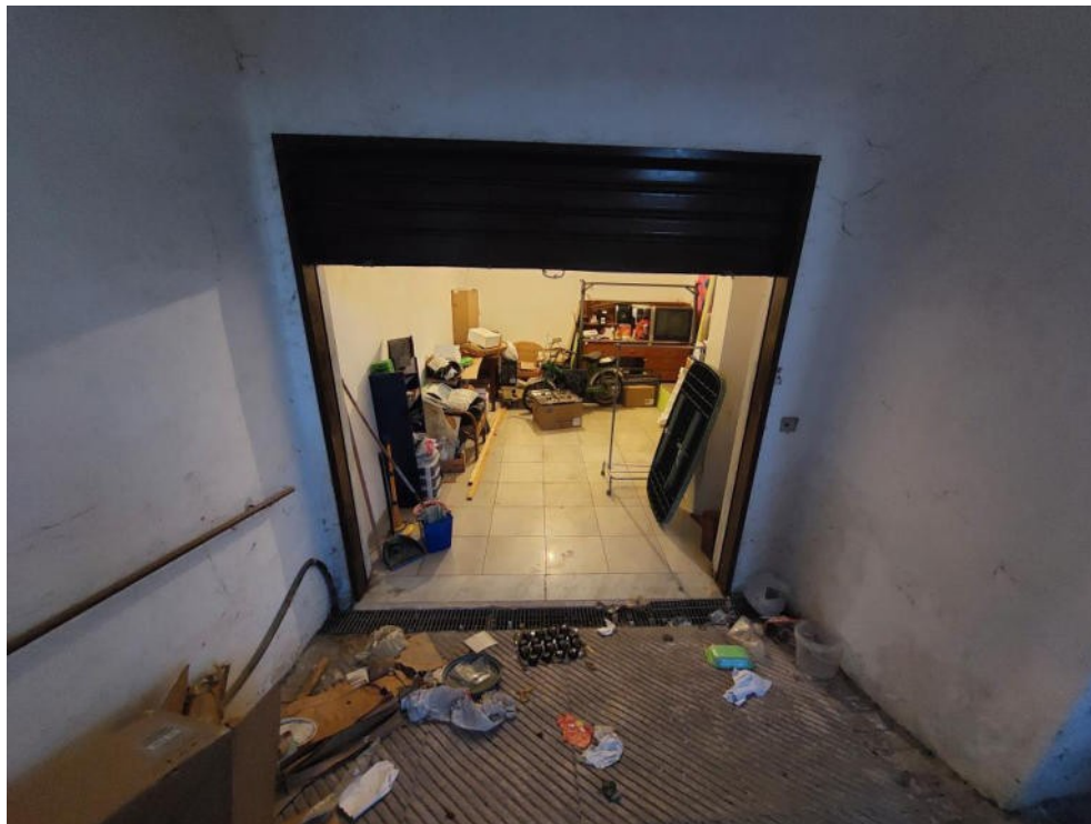
Foto 4 – scivolo coperto e ingresso carrabile al magazzino
