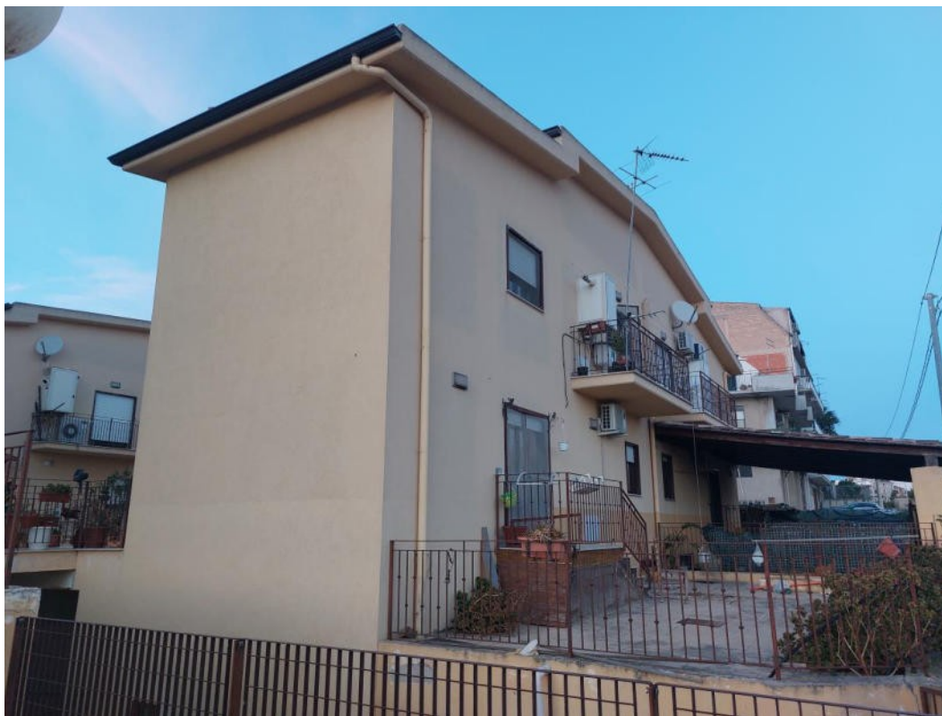
Foto 3 – prospetto sud est da corte condominiale (sub 1)
