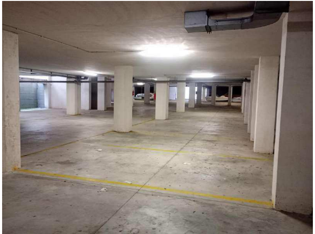
Autorimessa piano interrato
