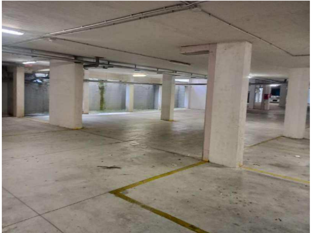
Autorimessa piano interrato
