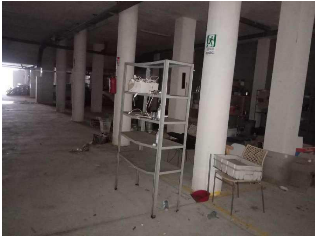
Autorimessa piano interrato
