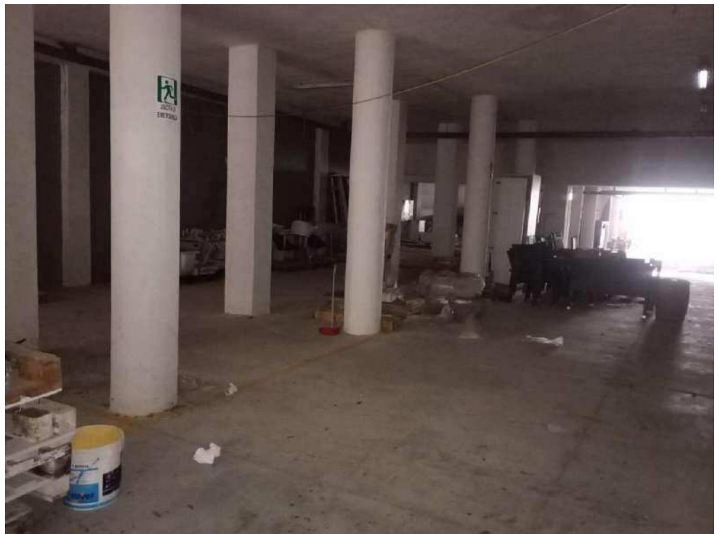
Autorimessa piano interrato
