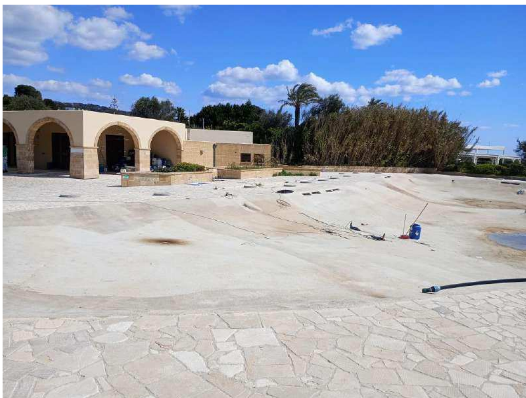
Piscine – in fase di manutenzione
