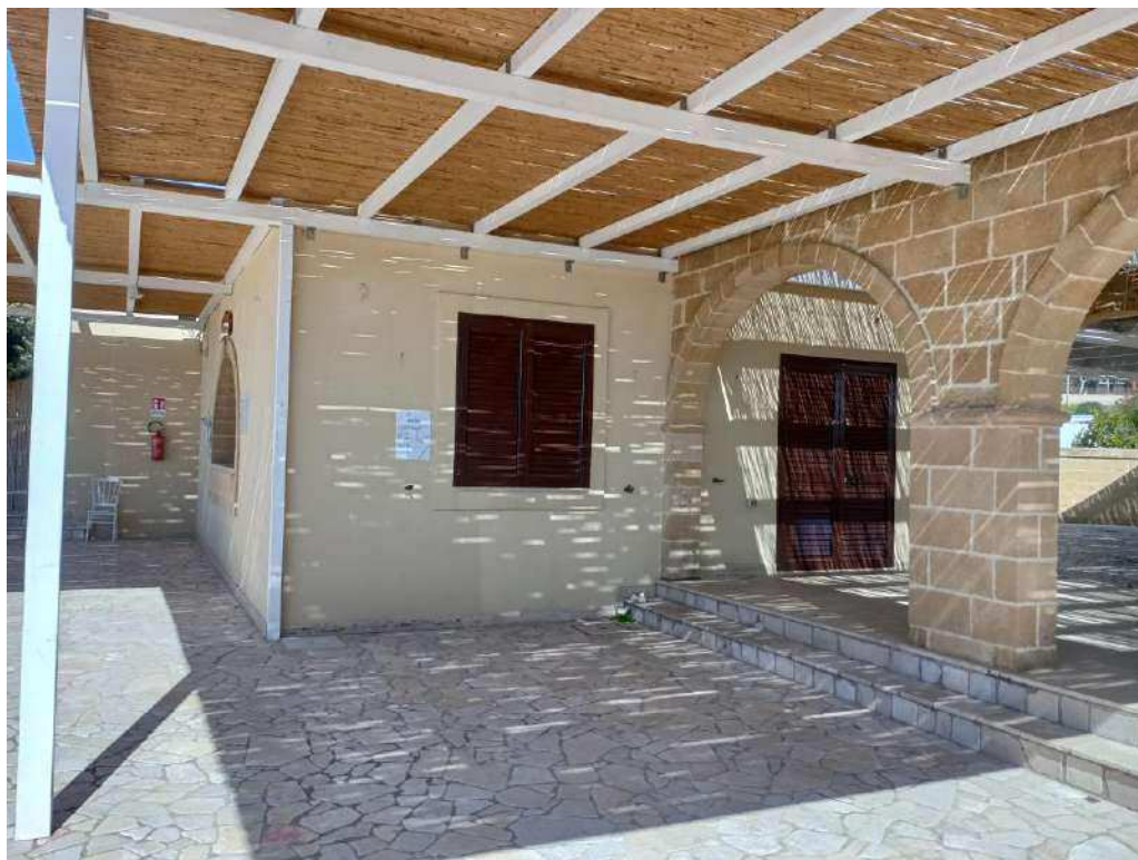
Blocco B - Bar e servizi sub. 1
