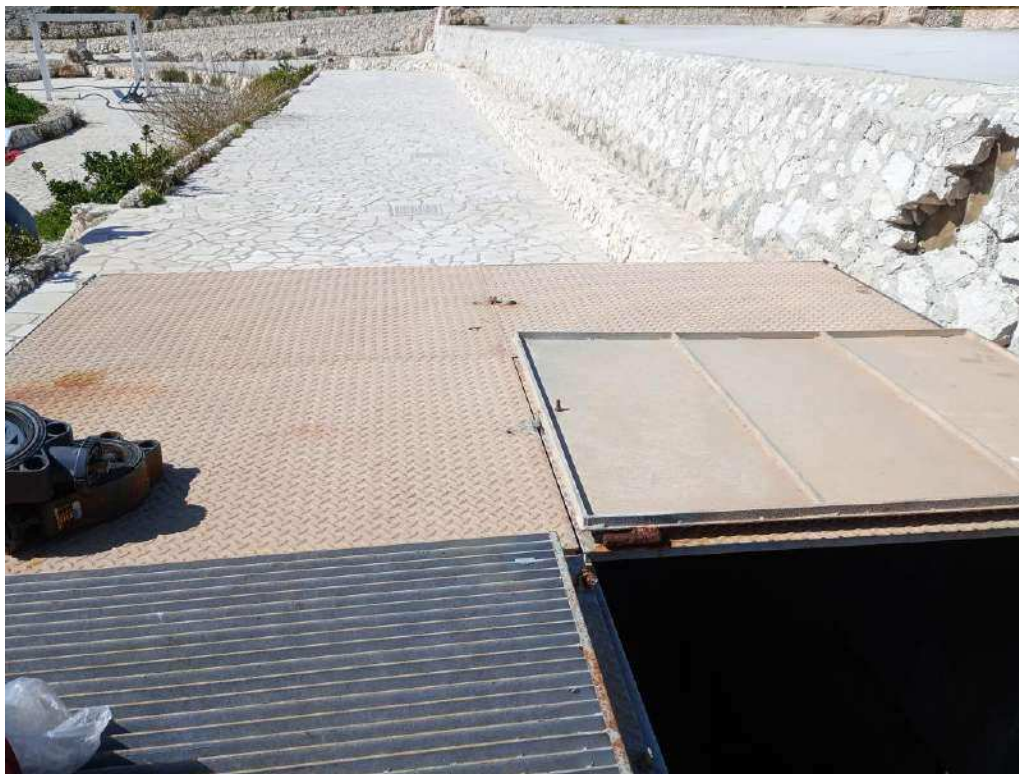
Blocco C - Locale tecnico sub.1
