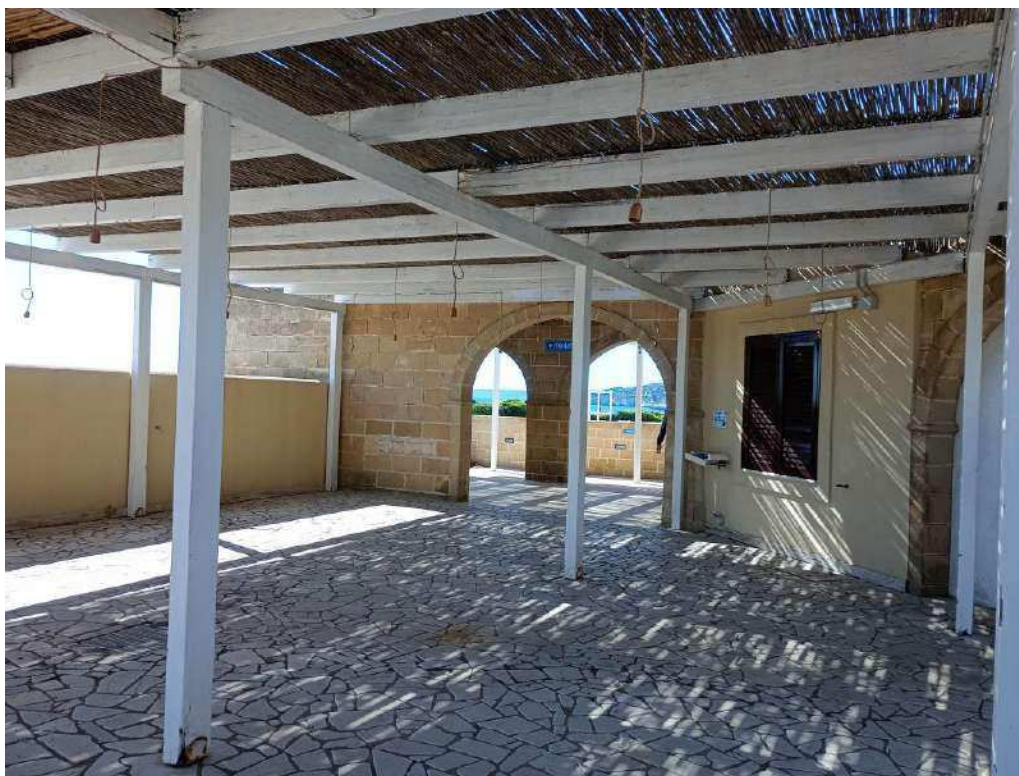
Blocco B - Bar e servizi sub. 1
