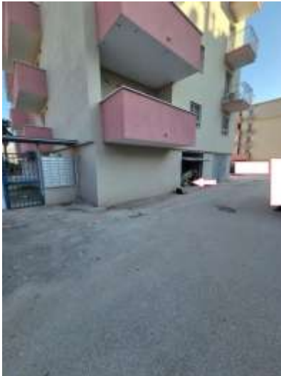
Figura 28 accesso al box auto pertinenziale pignorato al piano terra
