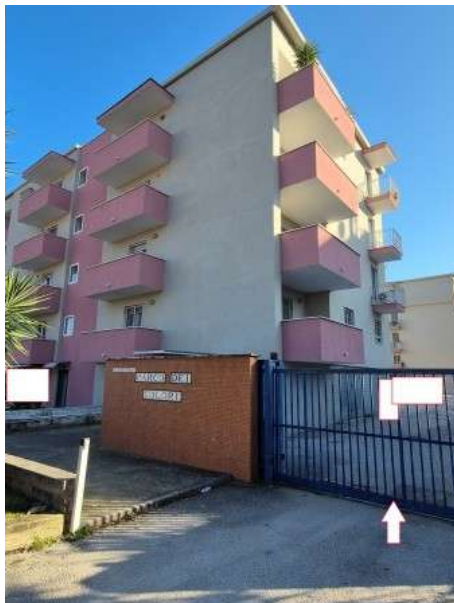
Figura 5 accesso carrabile al Condominio Parco dei Colori a cui appartiene l'immobile pignorato in San Prisco alla via Europa n.147
