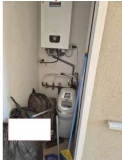
Figura 23 ripostiglio sul balcone dell'appartamento pignorato al primo piano
