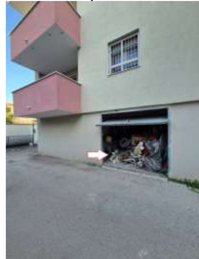
Figura 29 accesso al box auto pertinenziale pignorato al piano terra
