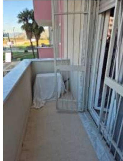
Figura 27 balcone 3 dell'appartamento pignorato al primo piano
