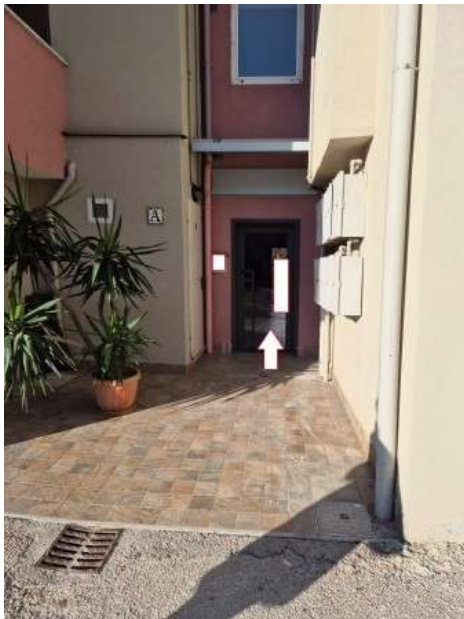
Figura 8 accesso al vano scala A del fabbricato
