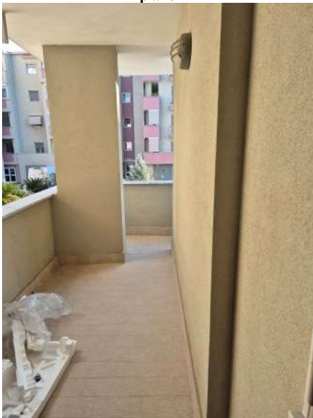
Figura 24 balcone 1 dell'appartamento pignorato al primo piano
