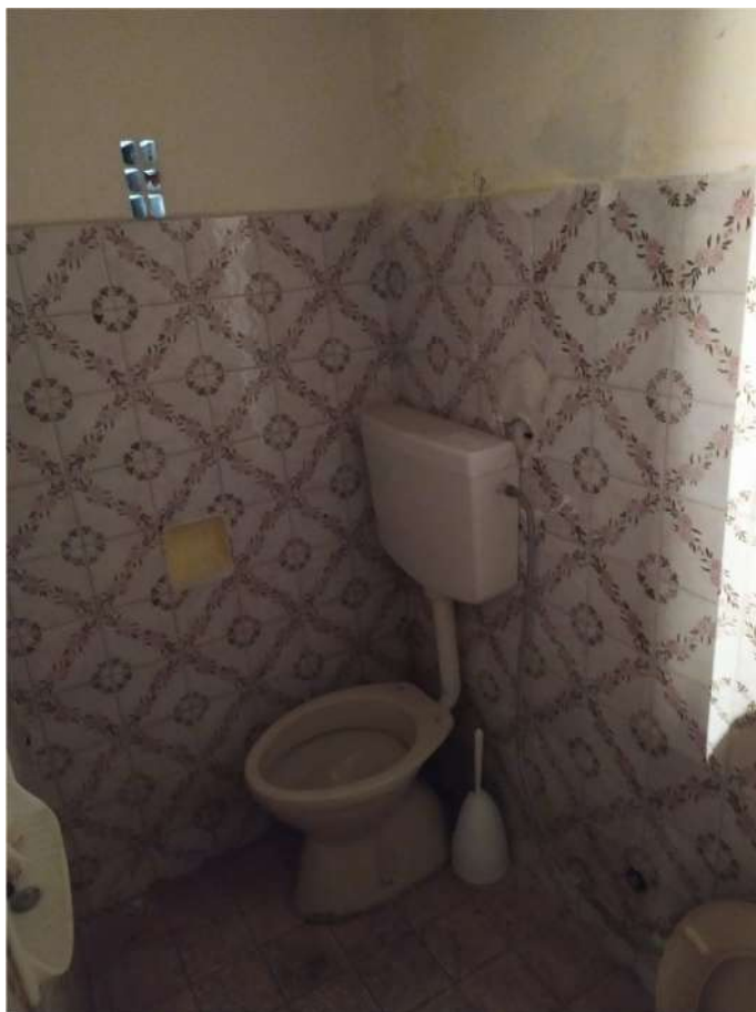
Foto 8 _ Lotto n. 1 _ Rivestimento pareti w.c.
