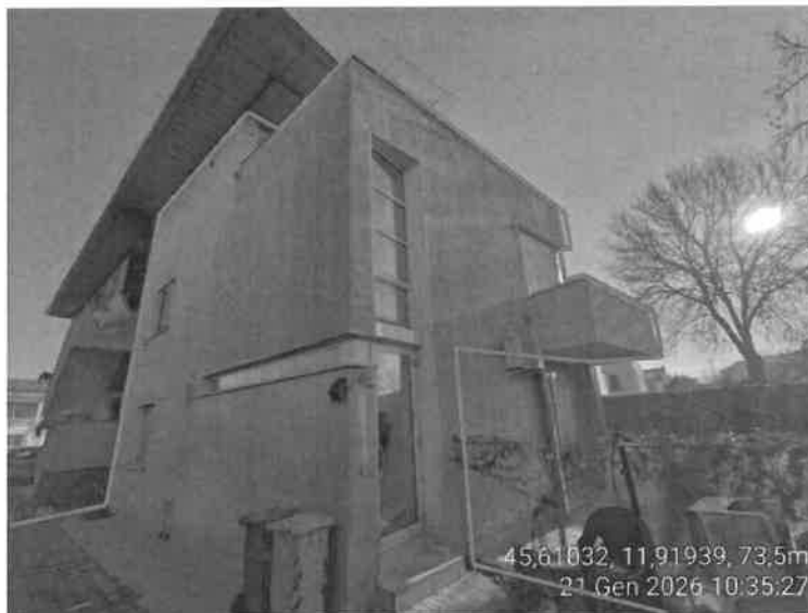
Lotto 1 – Immobile P.T., 1°-2°P con pertinenze Via Padre M. Bottacin, 9E - Loreggia (PD)
