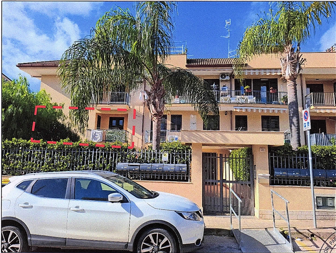
Foto 1 _Il condominio_Via L. Sciascia n.21_Vista esterna con individuazione dell'appartamento
