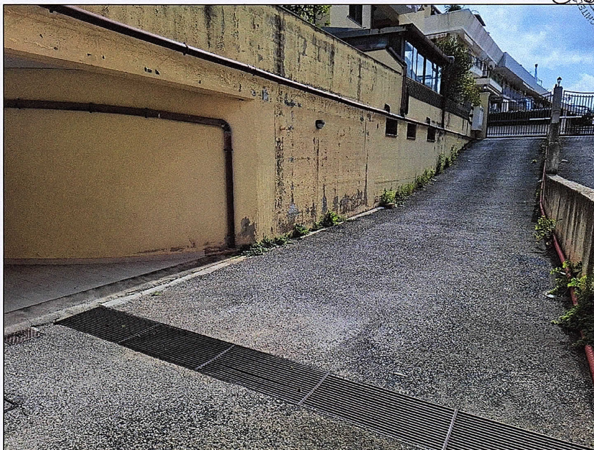
Foto 16_Passo carrabile su Via dei Platani e rampa d'accesso al piano seminterrato (box auto)
