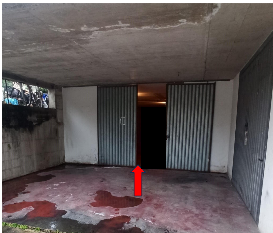
Foto 2 Ingresso area comune autorimesse
