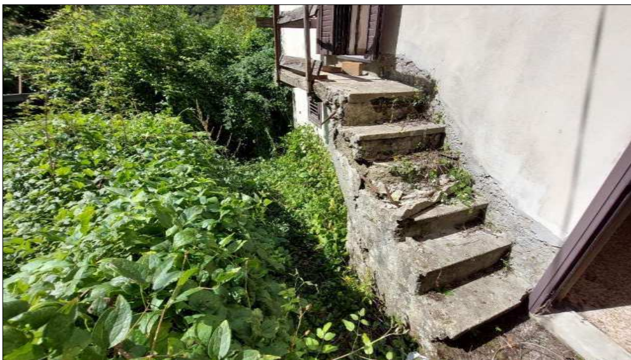
FOTO 11 RAMPA DI ACCESSO AL PIANO TERRA (MAPP. 1070)
