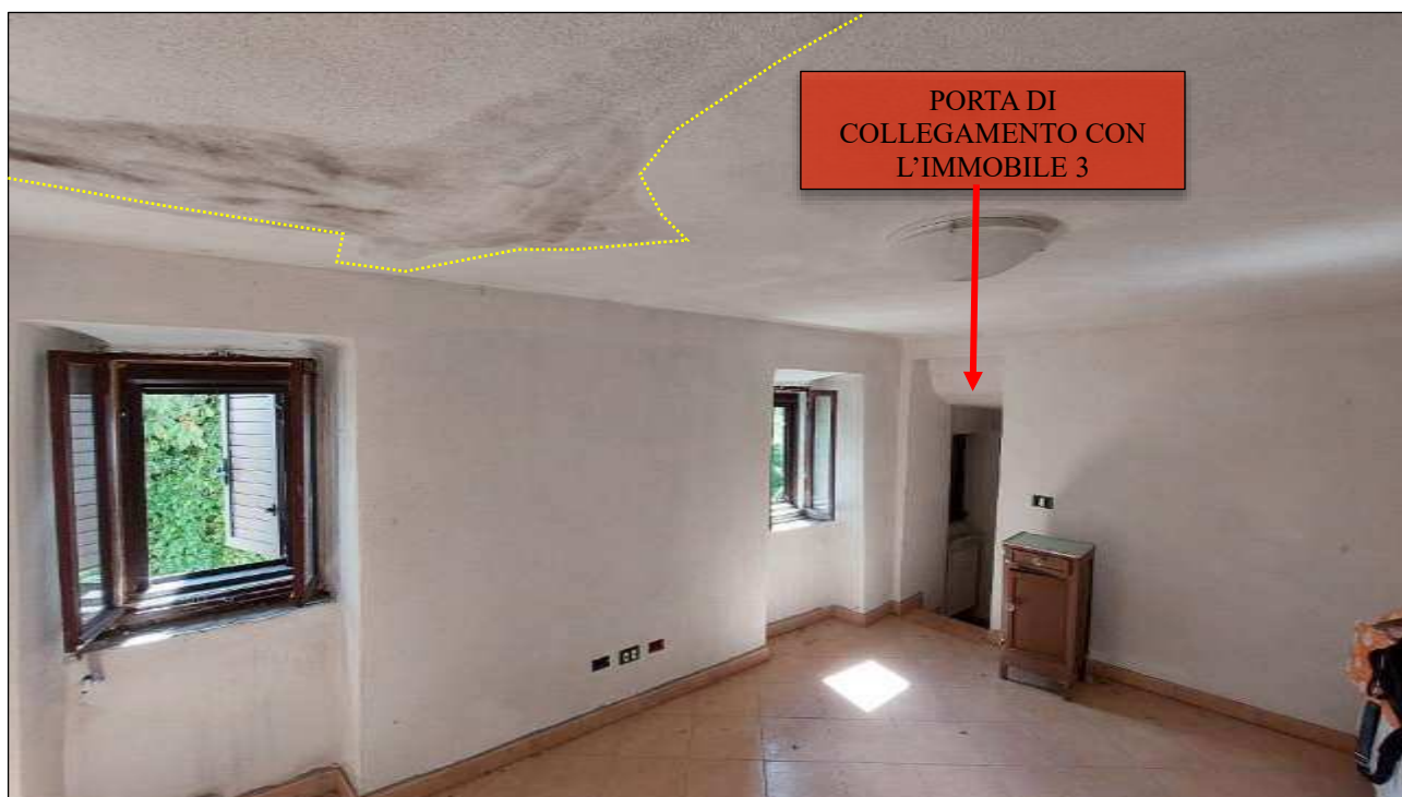
FOTO 34 – SOGGIORNO CON INDIVIDUAZIONE DELLE INFILTRAZIONI DALLA COPERTURA
