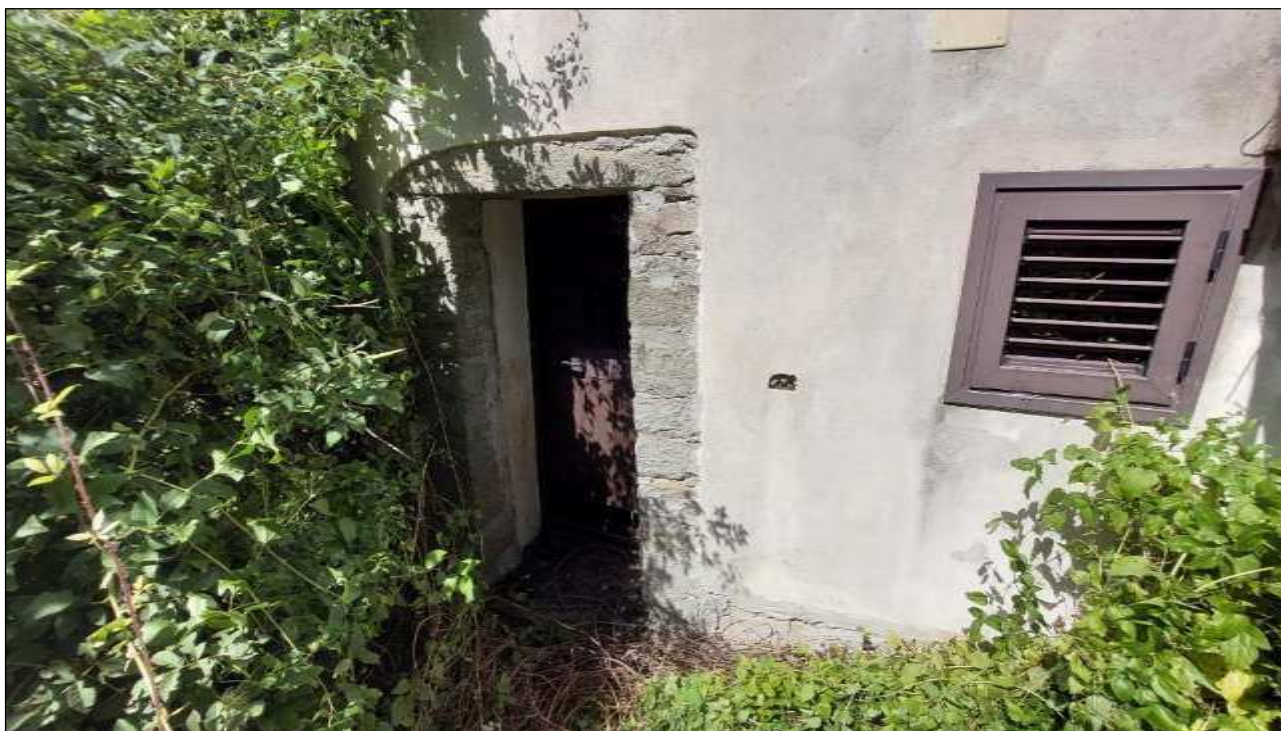
FOTO 1 – PORTA DI ACCESSO AL PIANO PRIMO SOTTOSTRADA (MAPP. 1070)
