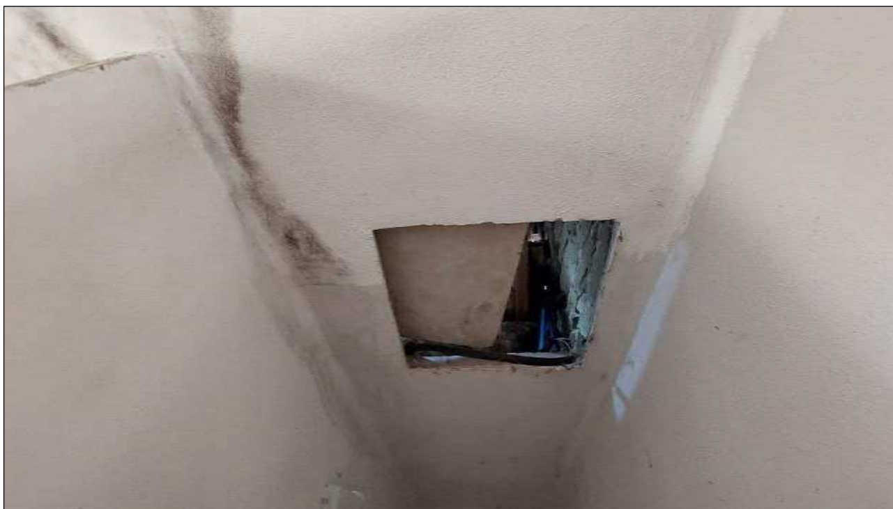
FOTO 32 – BOTOLA DI ISPEZIONE DEL SOTTOTETTO
