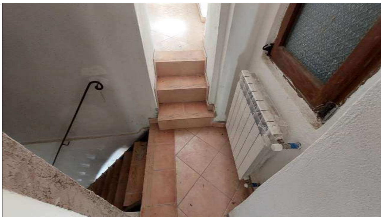
FOTO 33 – VARCO DI COLLEGAMENTO TRA GLI IMMOBILI 2 E 3
