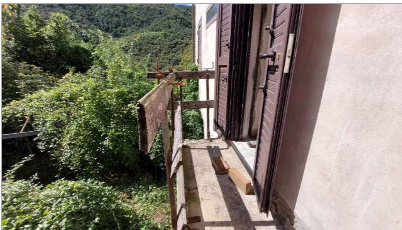
FOTO 12 – BALCONE DI ACCESSO AL PIANO TERRA
