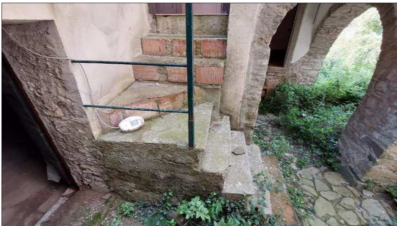
FOTO 12 – SCALA DI ACCESSO AL PIANO PRIMO
