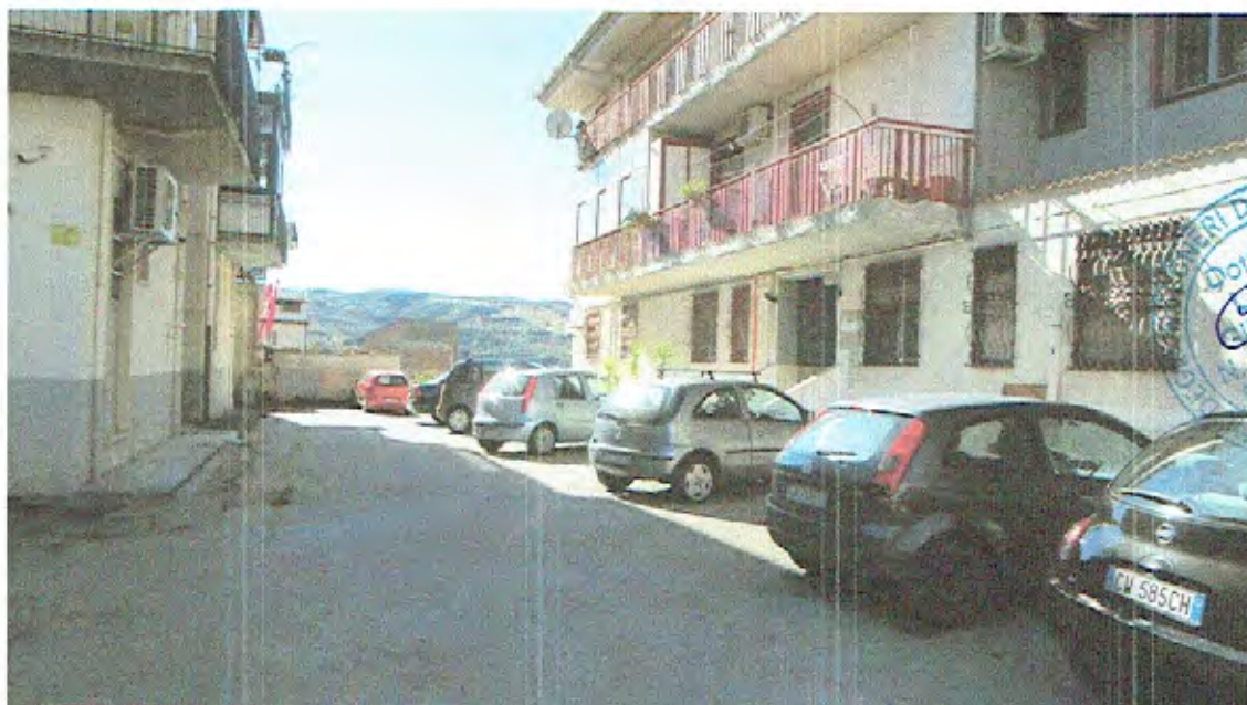
Foto n.03 - Prospetto Est (Piazzale di Accesso alla U.I.)
