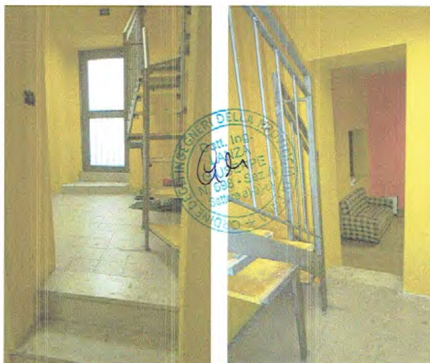
Foto n.07 - Apertura senza Porta (Comunicante con U.I. n.10)
