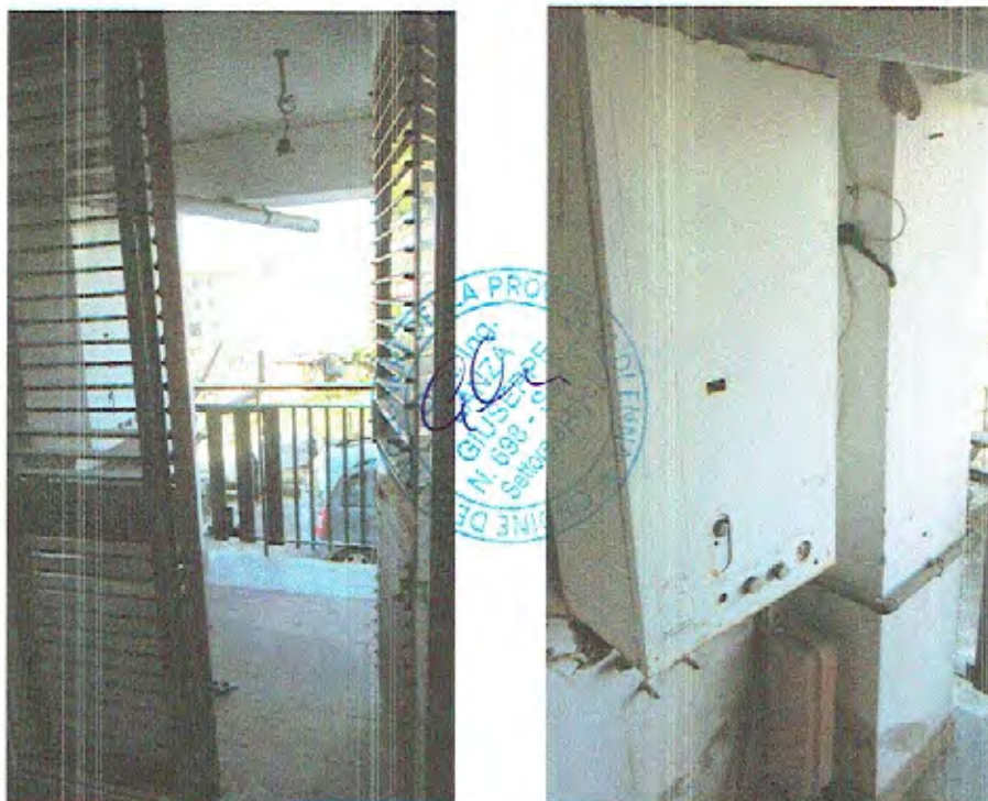
Foto n.17 - Terrazzino di Accesso dal Vano Cucina
