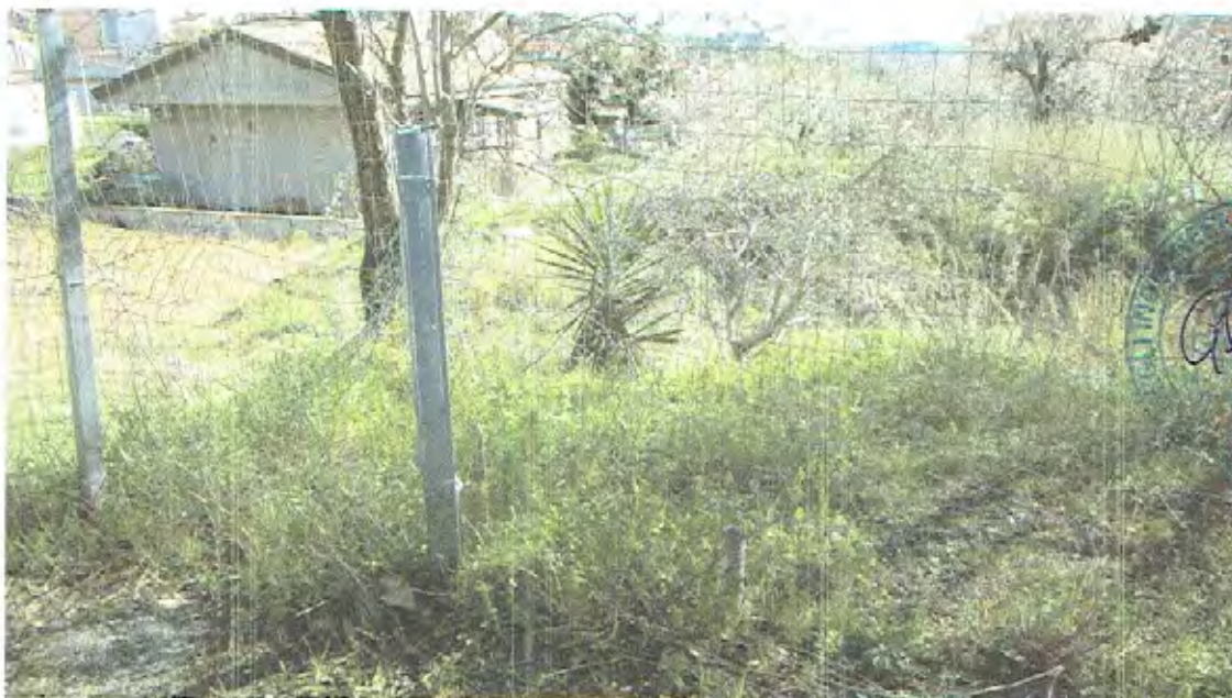
Foto n.45 - Recinzione della U.I.
