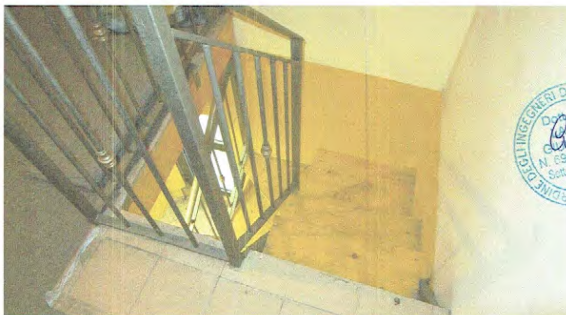
Foto n.13 - Vano Scala (Ferro-Legno) (Comunicante con U.I. n.8)
