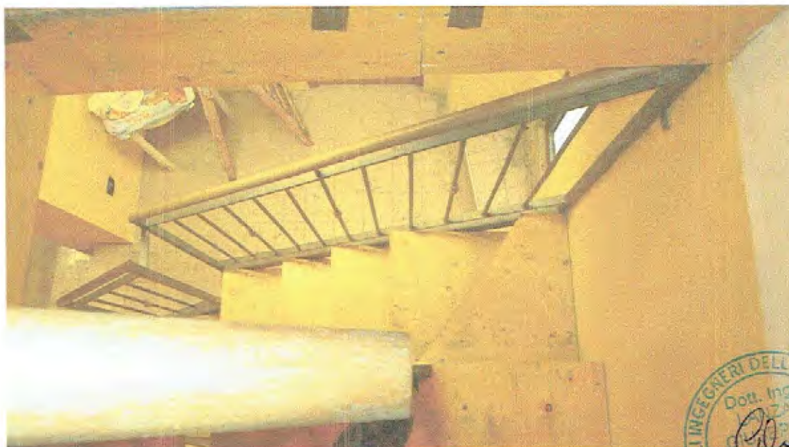
Foto n.08 - Vano Scala (Ferro-Legno) (Comunicante con U.I. n.9)
