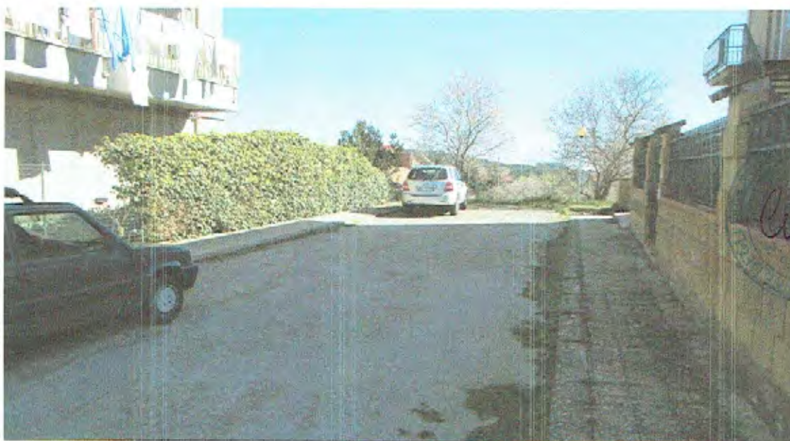
Foto n.42 - Strada di Accesso senza Sbocco
