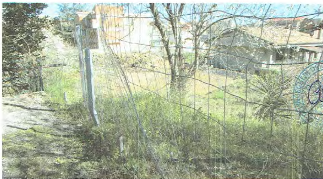
Foto n.44 - Recinzione della U.I. (Lato Ovest)
