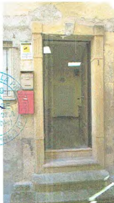
Foto n.17 - Prospecto Sud (Piano Terra - Entrata)
