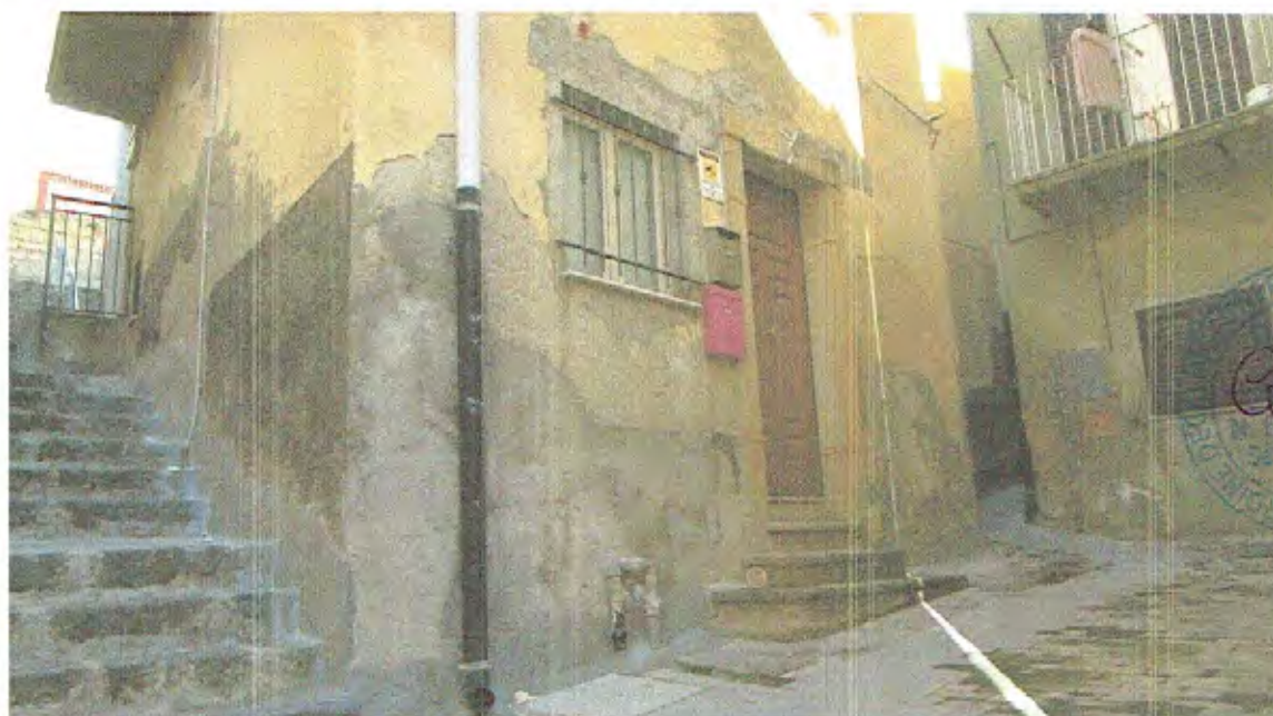
Foto n.14 - Prospetto Sud (Piano Terra - Entrata)
